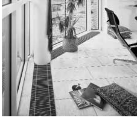
Şekil 2.8. Döşeme tipi konvektör uygulaması
