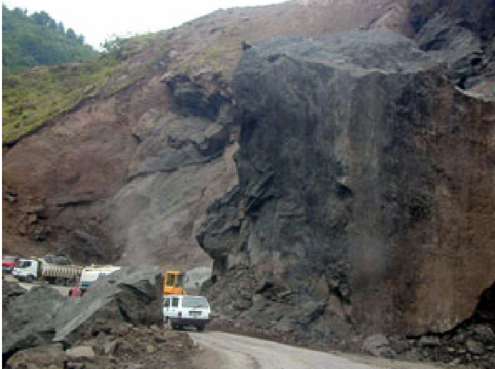
Şekil 1.2. Karadeniz sahil yolu yapımında kullanılan patlatma çalışması görüntüsü (www.kenthaber.com)
