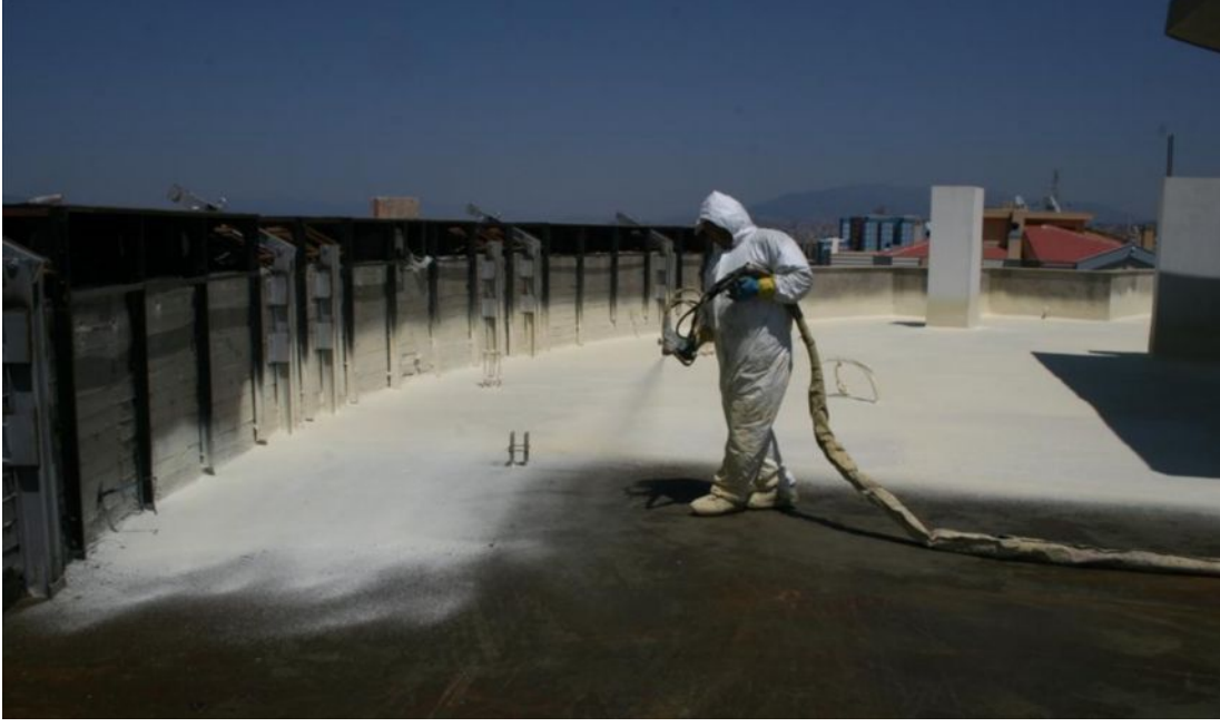
Şekil 8.1. Terasta püskürtme su yalıtımı uygulanması
