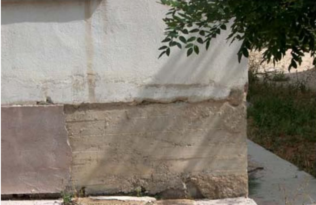
Şekil 3.4. Kılcal su yükselişleri hasara sebep olur
