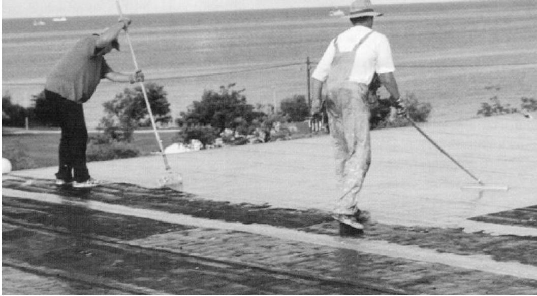
Şekil 8.2. Sürülerek uygulanan teras yalıtımı
