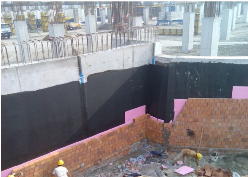
Şekil 7.1. Sürülerek yapılan yalıtımın korunması
