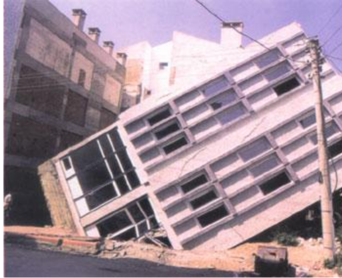
Şekil 1.16. Devrilen Bina Örneği - 1
