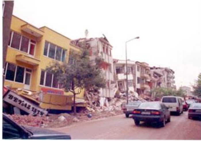
Şekil 1.6. Bitişik nizam yapılarında zayıf kat - 1
