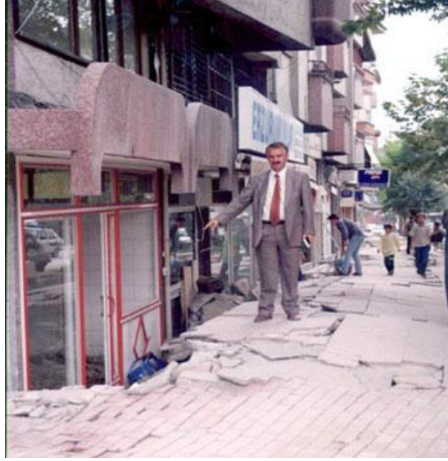
Şekil 1.24 . Binada Oturma - 2
