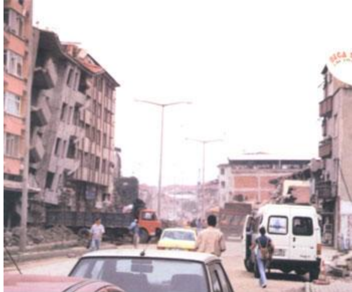
Şekil 1.9. Dilatasyon Derz Boşluğu Bırakılmaması - 2
