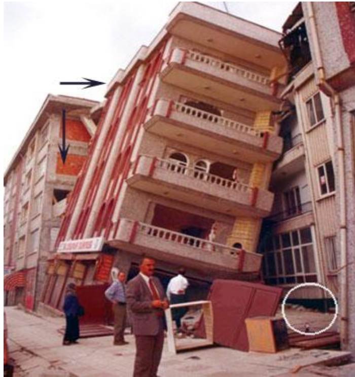
Şekil 1.19. Devrilen Bina Örneği - 2
