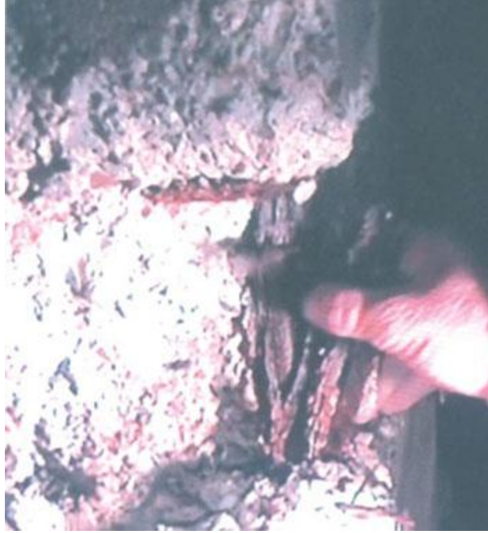
Şekil 1.26. Binada Korozyon - 1
