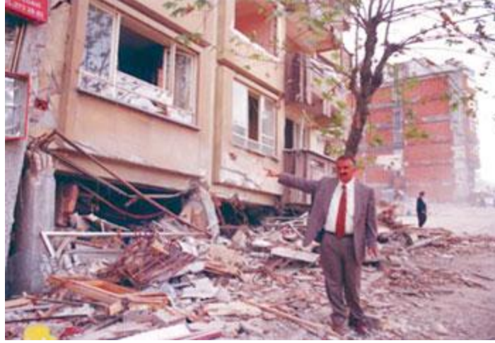
Şekil 1.4. Yumuşak kat örneği - 1
