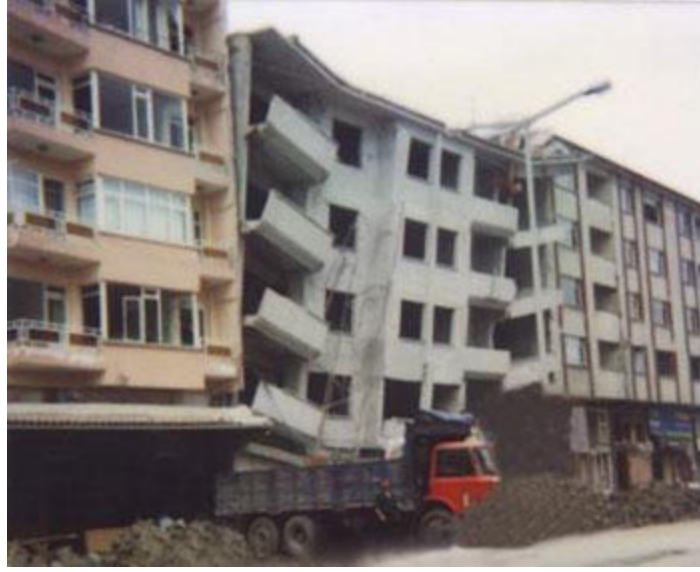
Şekil 1.10. Dilatasyon Derz Boşluğu Bırakılmaması - 3
