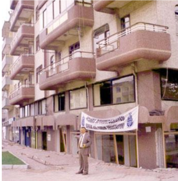
Şekil 1.23. Binada Oturma - 1
