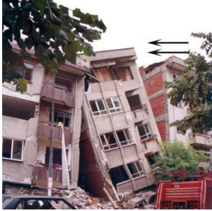
Şekil 1.11. Dilatasyon Derz Boşluğu Bırakılmaması - 4
