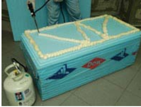
Şekil 3.32. Poliüretan esaslı malzeme ile plaka üzerine yalıtım yapıştırma uygulaması
