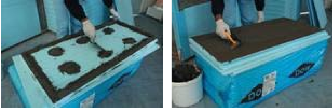
Şekil 3.31. Plaka üzerine yalıtım yapıştırma harcı uygulaması
