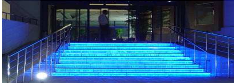
Şekil 2.19. Fiber optik kablo kullanarak merdiven aydınlatması [2]
