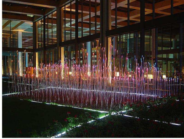
Şekil 2.21. Fiber optik kablo ile estetik aydınlatma uygulaması
