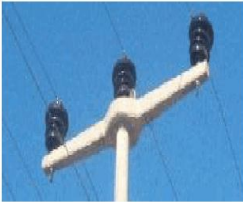
Şekil 4.3. Direklerde OG İzolatörleri
