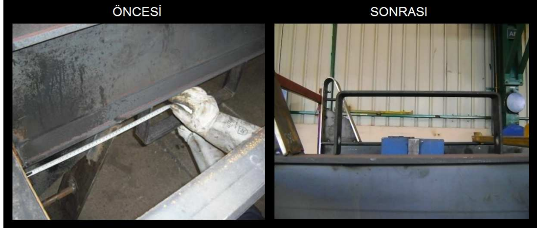
Şekil 4.22. Katlanır merdiven bağlantı köşebenti puntalama operasyonu
