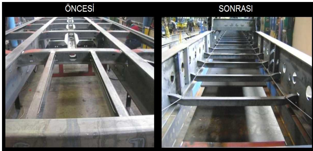
Şekil 4.23. Fren tesisatı bağlantıları puntalama operasyonu
