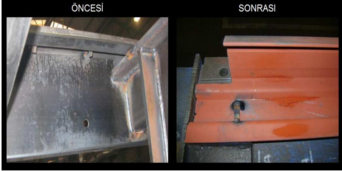
Şekil 4.26. Kablo kancası puntalama operasyonu
