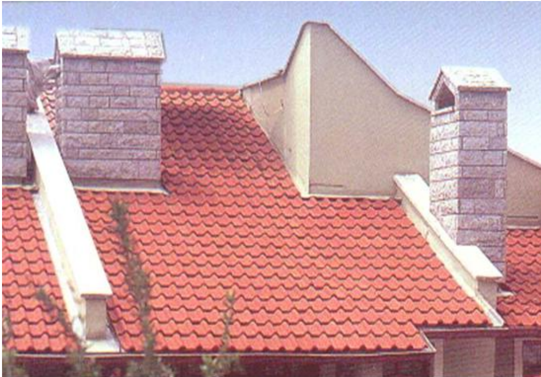
Şekil 6.10. Valensiya kiremit ile döşenmiş çatı
