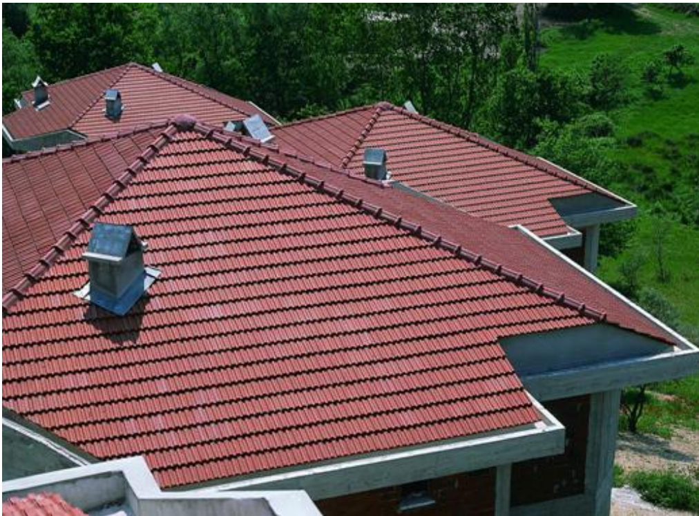
Şekil 6.5. Marsilya kiremit ile döşenmiş çatı
