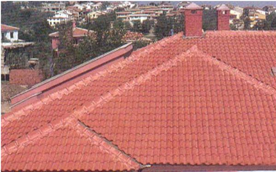
Şekil 6.8. Granada kiremit ile döşenmiş çatı
