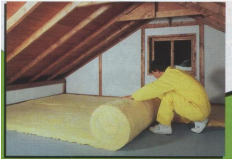
Şekil 6.13. Camyünü ile Isı ve ses yalıtımı
