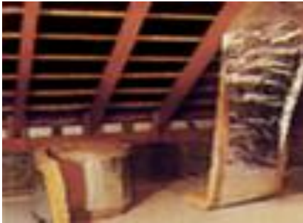
Şekil 6.14. Mertek arası camyünü ile ısı ve ses yalıtımı
