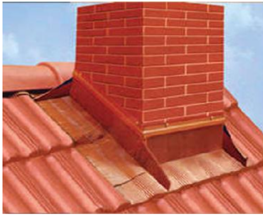
Şekil 6.12. Baca detay uygulaması
