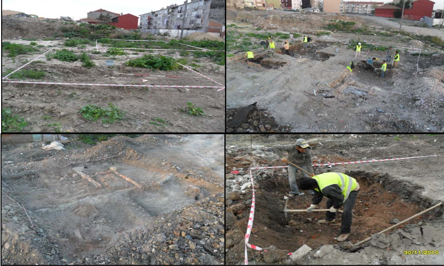
Ek G1. 119 Ada'ya ait temel kalıntıları görüntüleri
