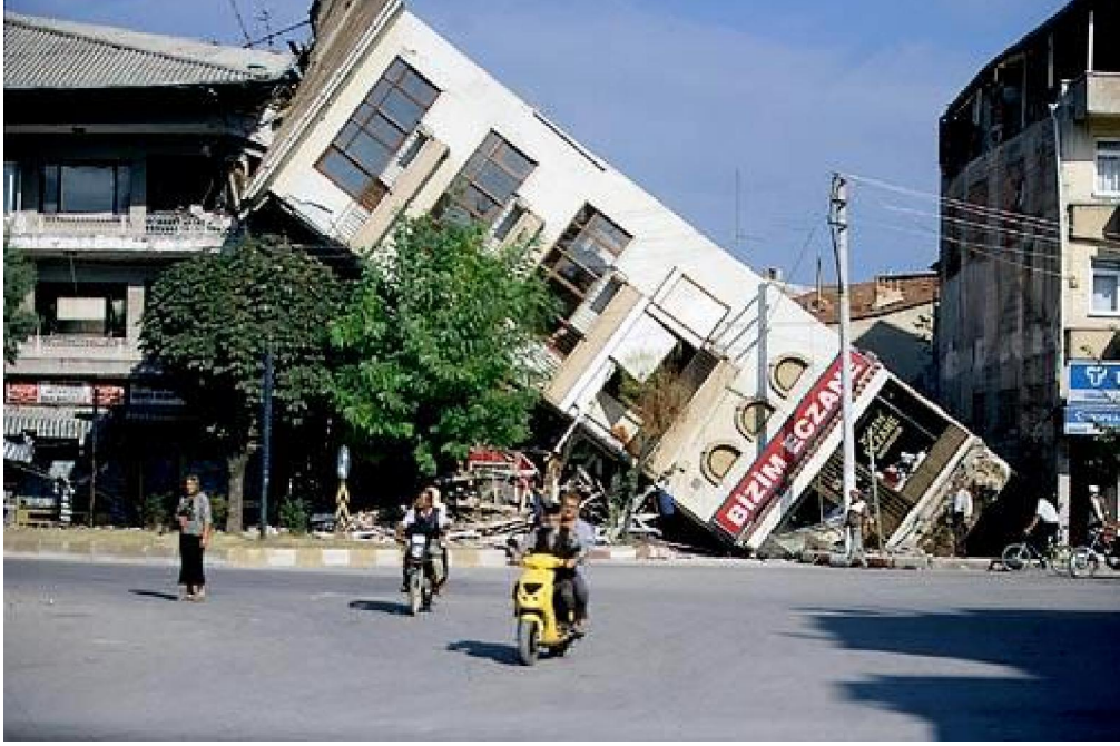
Şekil 1.3. 17 Ağustos 1999 Depreminde Adapazarı'nda Yan Yatan Bina
