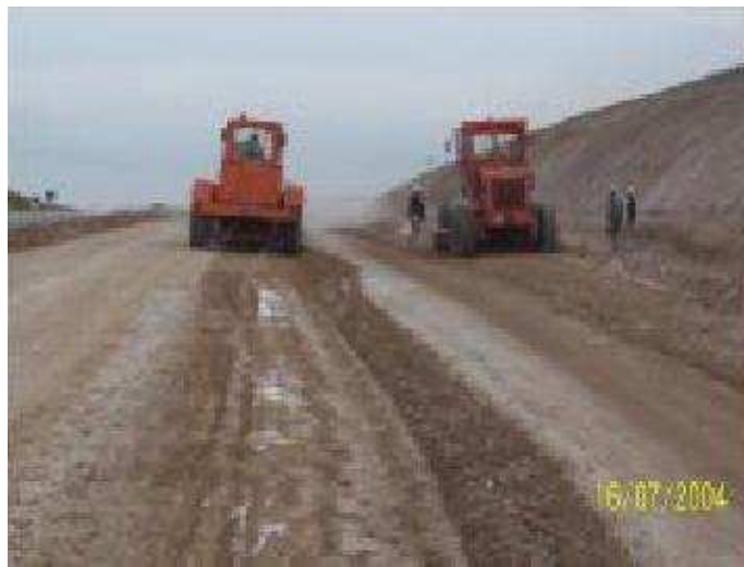
Şekil 3.4. Greyder İle Zeminin Düzlenmesi Aşaması
