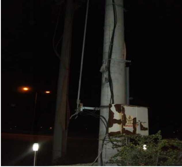
Şekil 5.3.Trafo direği sigortalı ayırıcı kolu altı ölçüm
