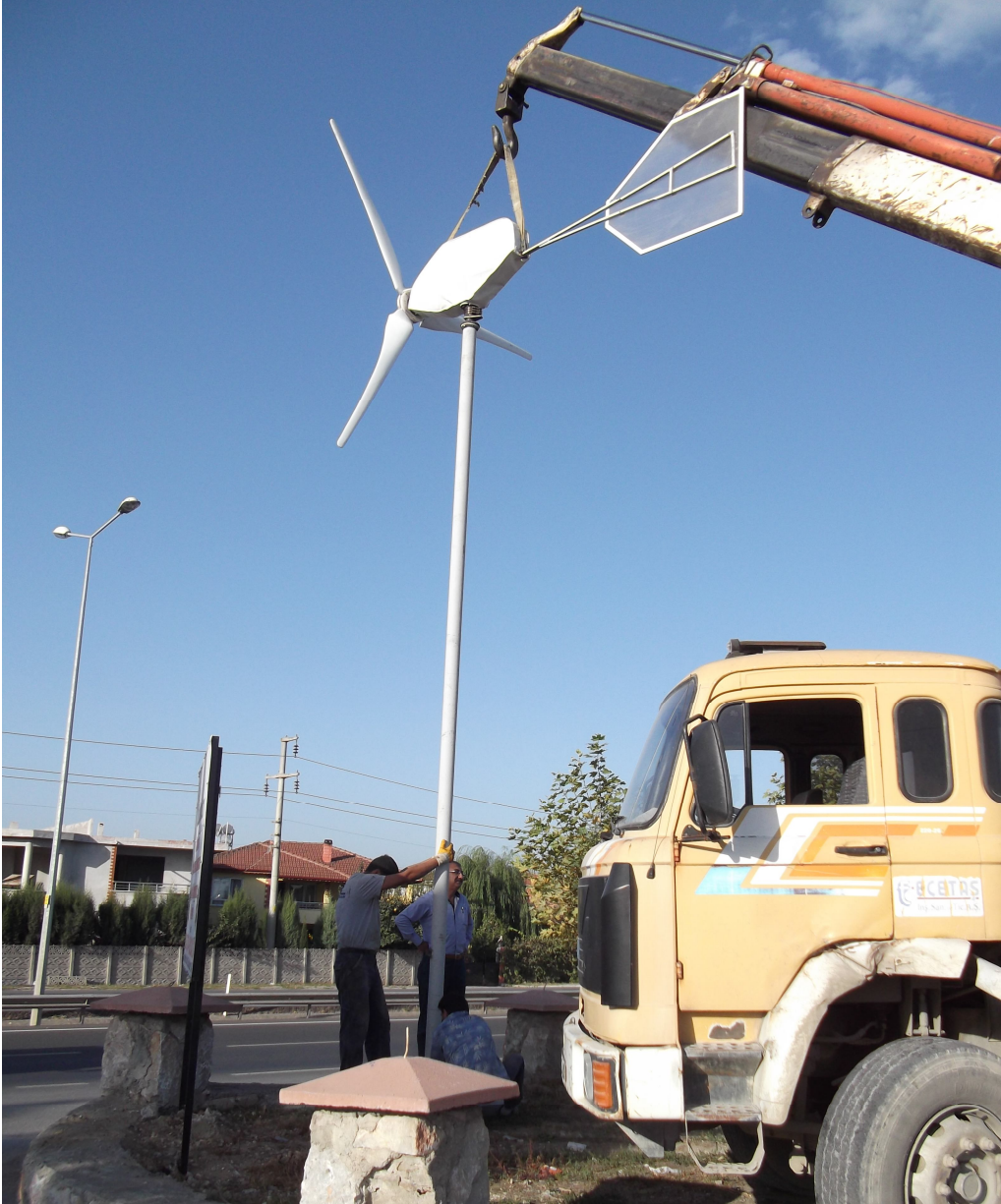
Şekil 5.29. Sistemin Ankraj Zeminine Montaj Edilmesi
