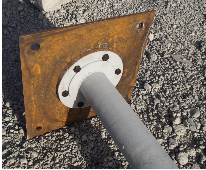
řekil 5.18. elik Boru Zemin Bađlantısı
