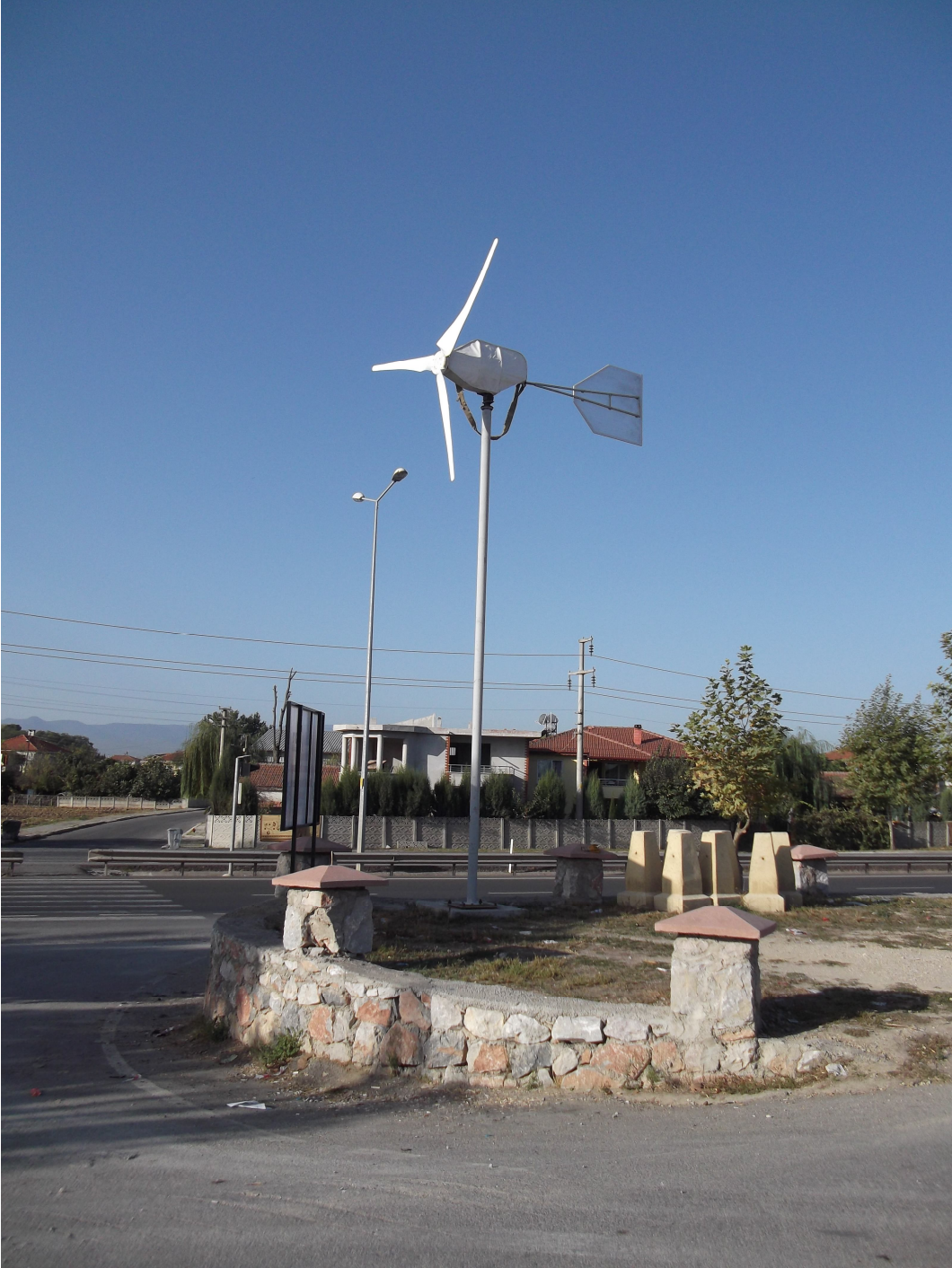
Şekil 5.30. Montaj İşlemi Tamamlanan Türbin
