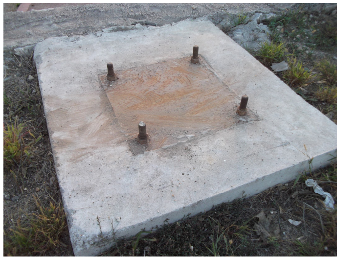
řekil 5.19. elik Boru Zemin Ankrajı
