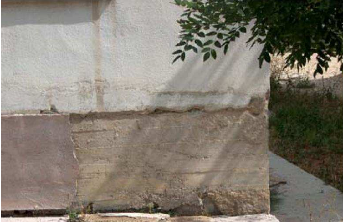
Şekil 3.4. Kılcal su yükselişleri hasara sebep olur
