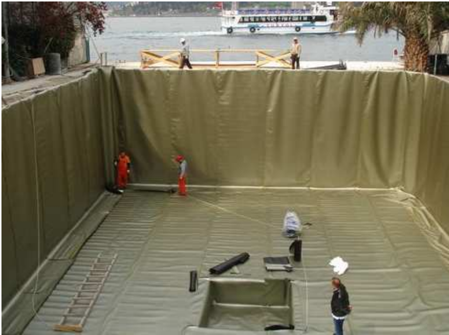
Şekil 5.1. Dıştan bohçalama yöntemi
