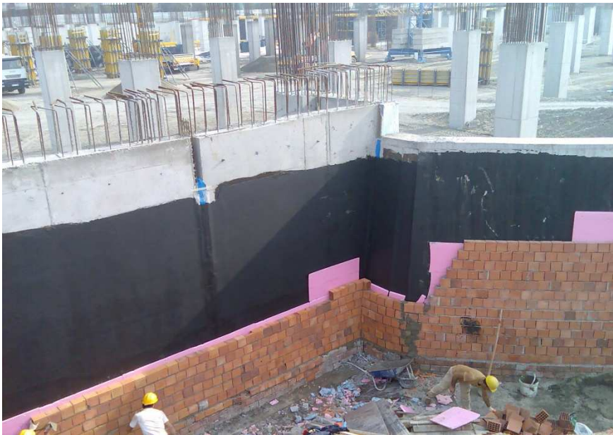
Şekil 7.1. Sürülerek yapılan yalıtımın korunması
