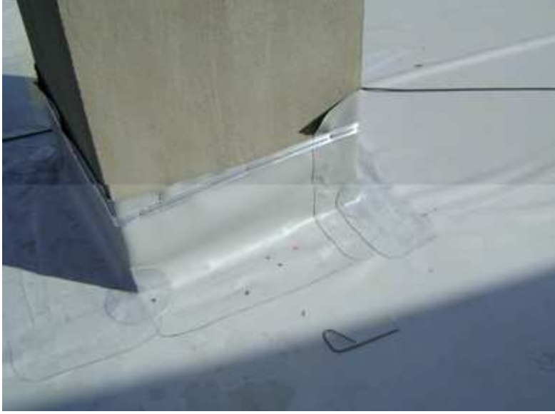
Şekil 8.3. Teras yalıtımında baca detayı
