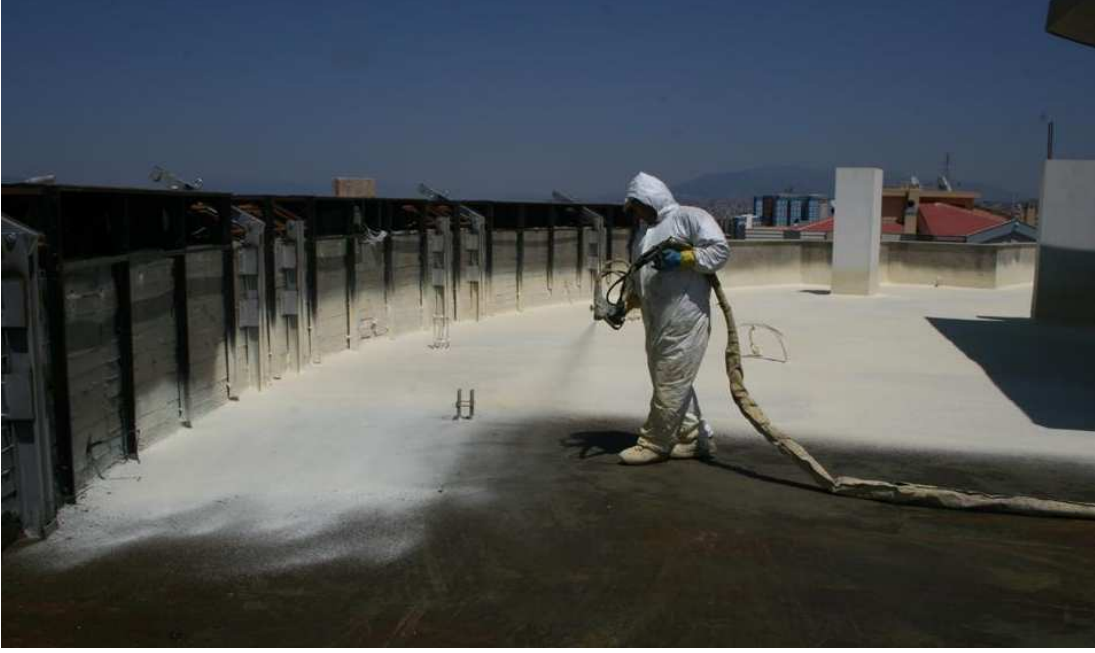
Şekil 8.1. Terasta püskürtme su yalıtımı uygulanması
