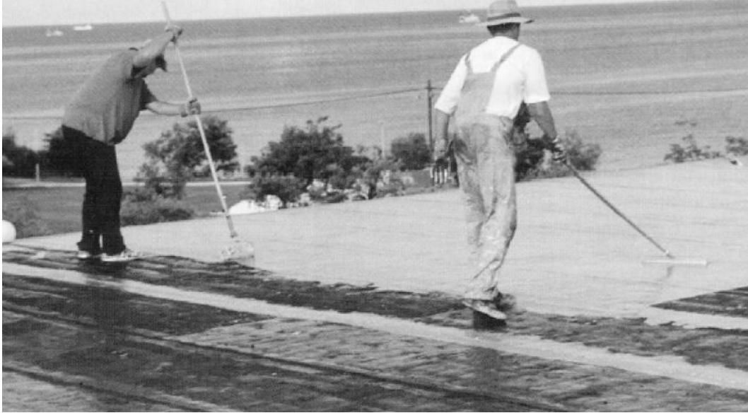
Şekil 8.2. Sürülerek uygulanan teras yalıtımı
