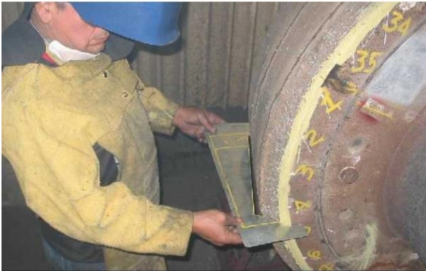
Şekil 4. 34. Dolgu işlemi bittikten sonra master yardımı ile dolgu kontrolü yapılıyor
