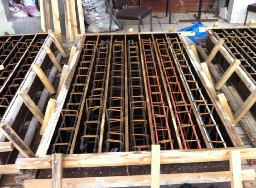
Şekil 4.9. Kiriş kalıplarına yerleştirilmiş donatıları
