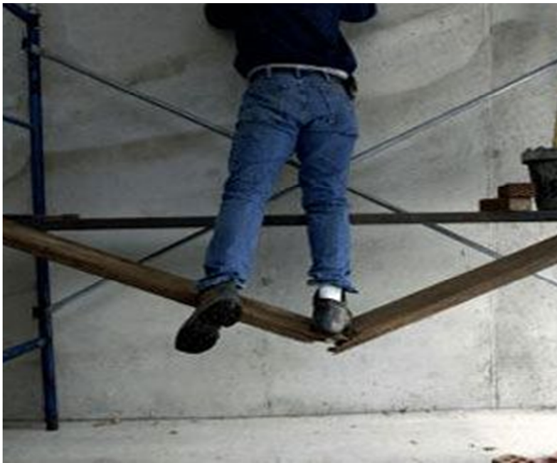
Şekil 3.18. Ahşap – Demir iskelede düşme anı [6]
