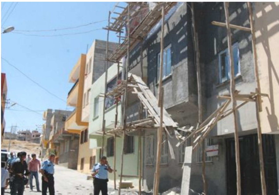
Şekil 3.22. Esneyen, çürüten ve kırılan kalas [6]
