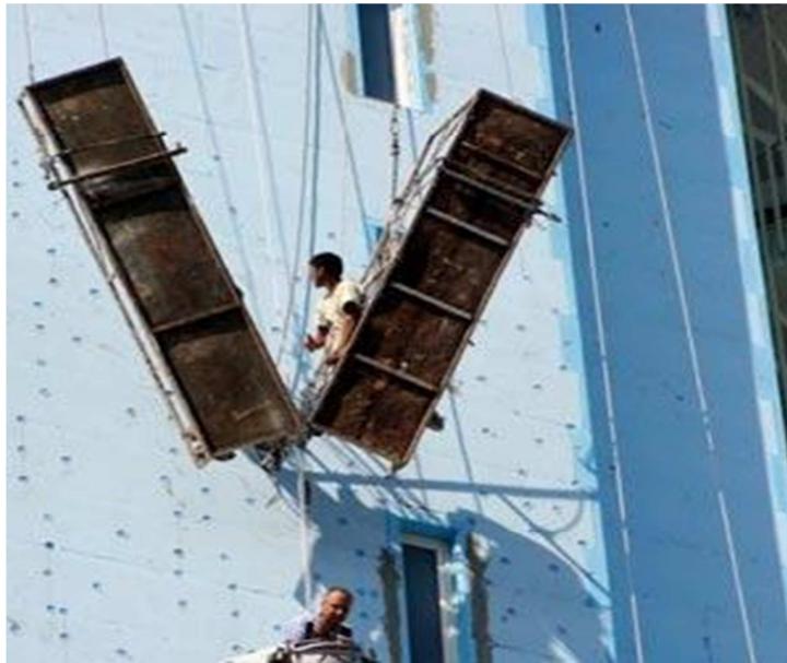
Şekil 3.24. Halatın kopması ile kırılan asma iskele [6]
