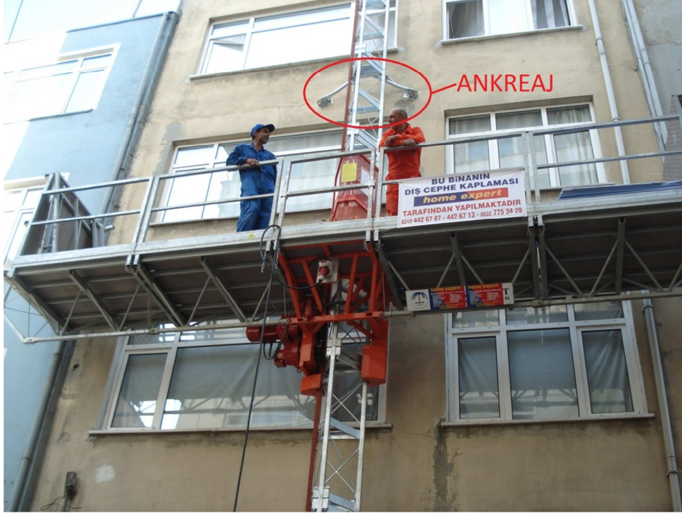
Şekil 3.25. Duvara ankraj ile sabitlenen HCI
