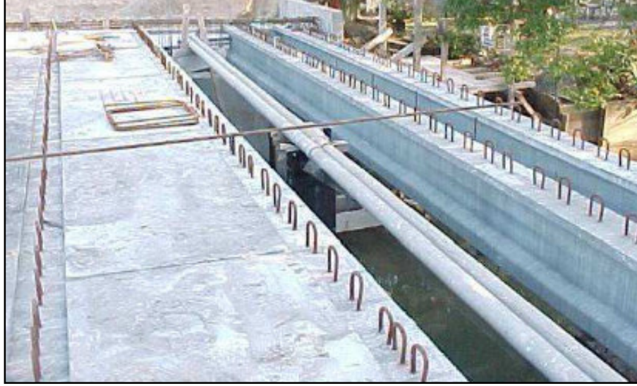
Şekil 2.7. Shepherds ırmağı üzerindeki, RPB kullanılarak yapılan ilk araç köprüsü kirişi [33]
