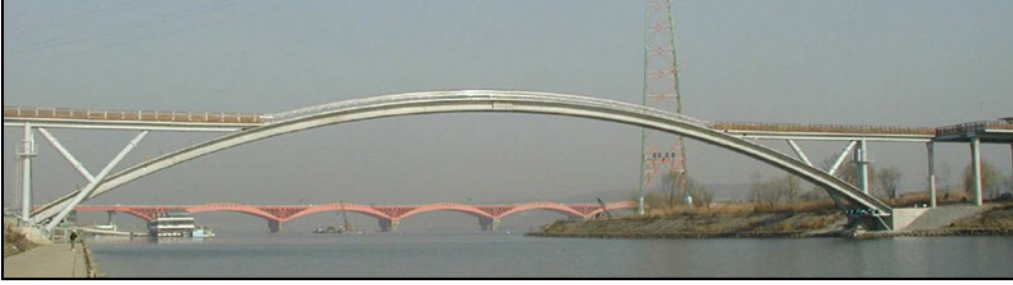
Şekil 2.11. Sunyudo'da üzerinde RPB kullanılarak yapılan ilk yaya köprüsü [37]
