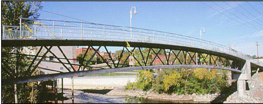
řekil 2.1. Sherbrooke řehrindeki RPB ile üretilmiř yaya köprüsü [6].
