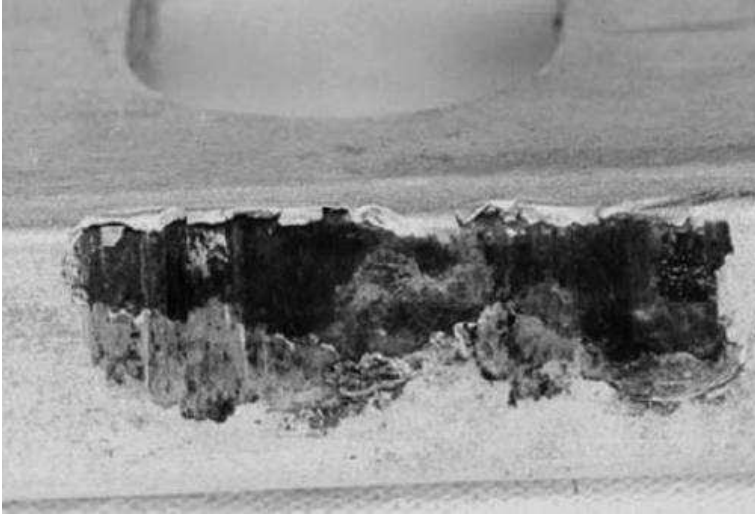
Şekil 2.12. Yüzeyde meydana gelen korozif aşınma [30]
