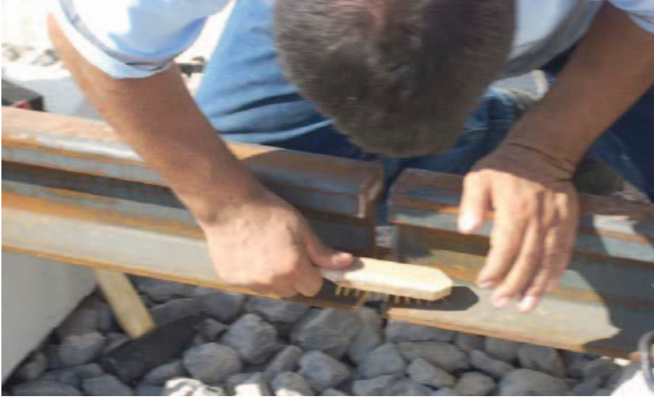
Şekil 04.2. Kaynak bölgesinin hazırlanması
