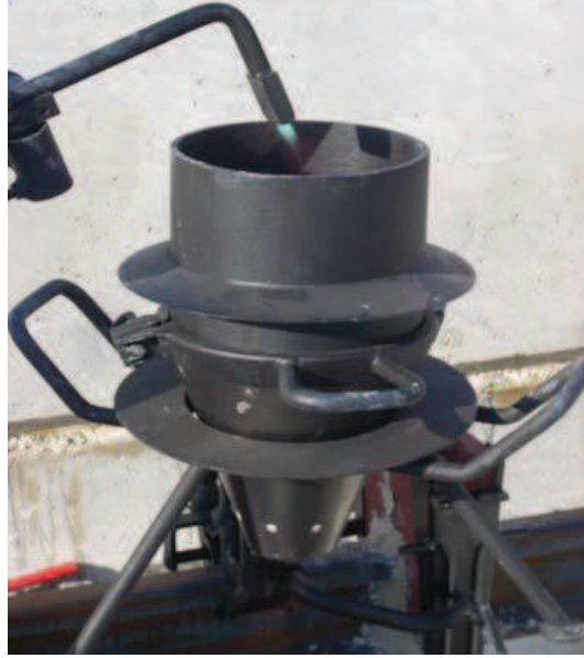
Şekil 4.5. Kaynak potasına şaloma yardımıyla ön ısıtma işleminin uygulanması
