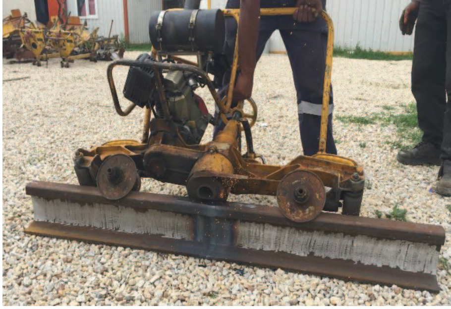
Şekil 6.5. Kaynak fazlalıklarının sıyırılması ve taşlama işlemi
