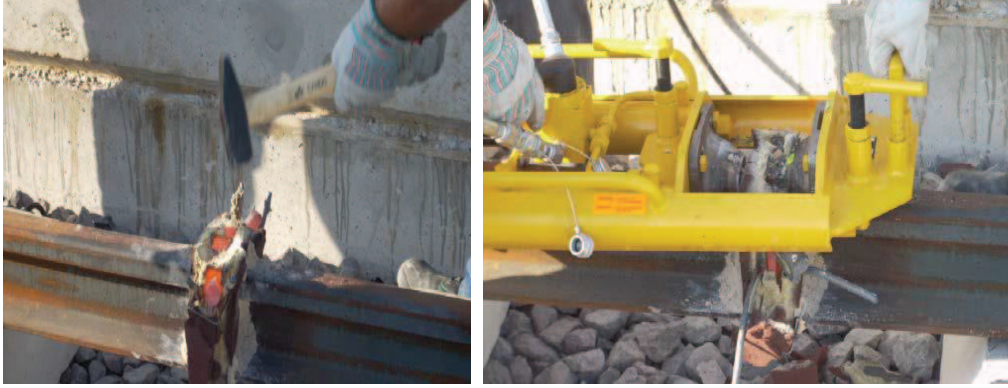
Şekil 4.7. Kaynak sıyırma makinesi ile kaynak sıyırma işlemi
