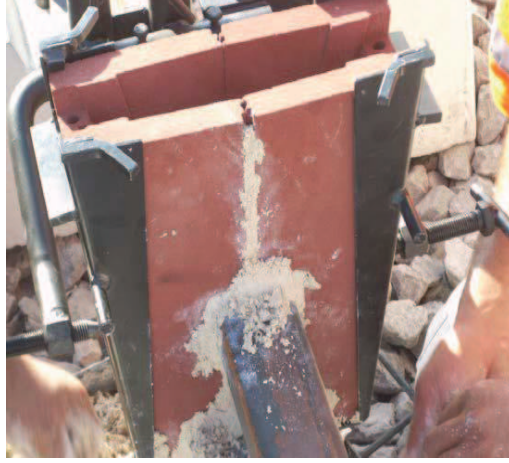
Şekil 4.4. Kalıp bağlanması ve macunlama işlemi
