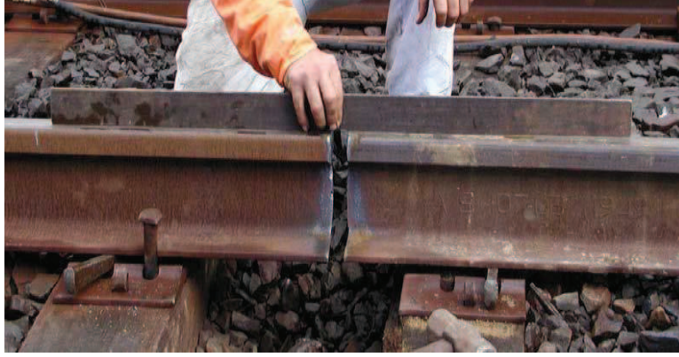
Şekil 4.3. Masterlama işlemi
