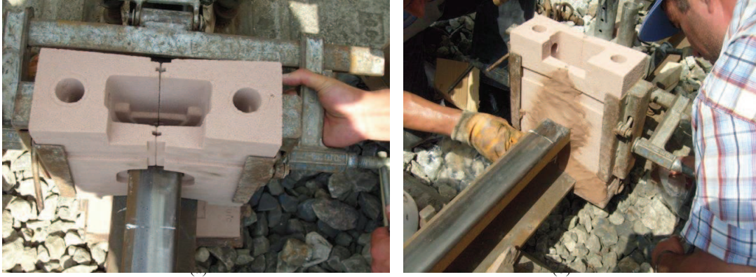
Şekil 6.3. Kalıp bağlanması ve macunlama işlemi
