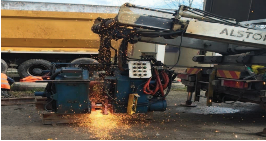
Şekil 6.2. Yakma alın kaynağı yapımı
