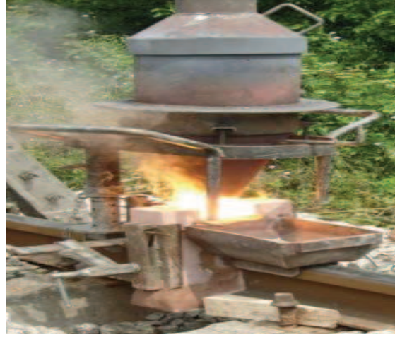
Şekil 6.4. Döküm işlemleri
