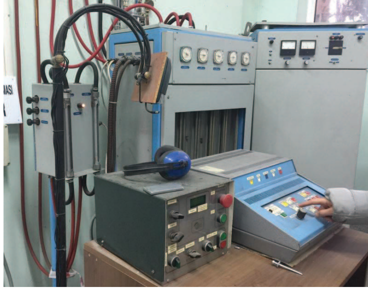
Şekil 6.2. Atım plazma kontrol paneli ve güç üniteleri
