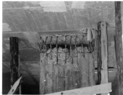
Şekil 2.4. Kolon-kiriş birleşiminde etriye eksikliğinden dolayı meydana gelen hasarlar
