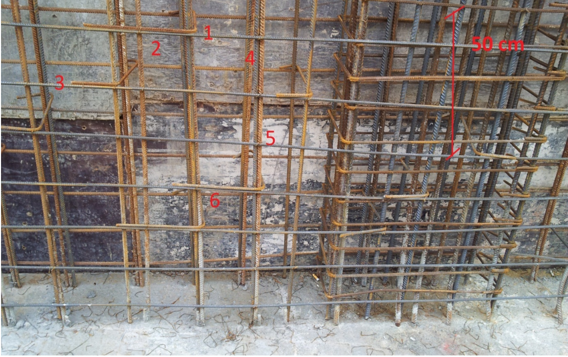
Şekil 3.32. Perdelerde çiroz sayısının uygun olmaması durumu
