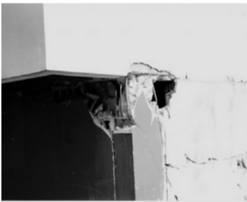
Şekil 2.4. Kolon-kiriş birleşiminde etriye eksikliğinden dolayı meydana gelen hasarlar
