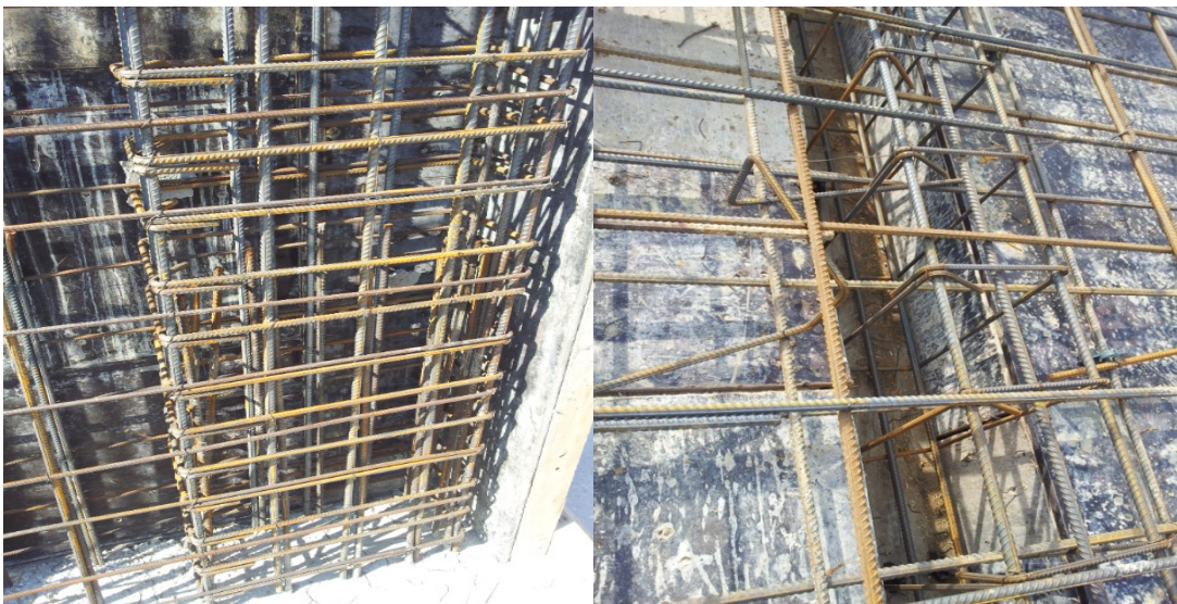
Şekil 3.3. (a) Kolonlarda (b) kirişte etriye kancalarının 135 derece yapılmaması
