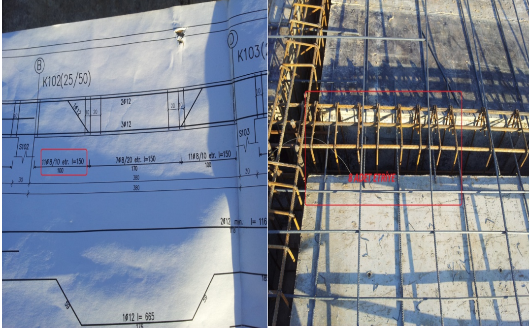
Şekil 3.16. Kiriş sarılma bölgesi uzunluğu şartına uyulmaması durumu
