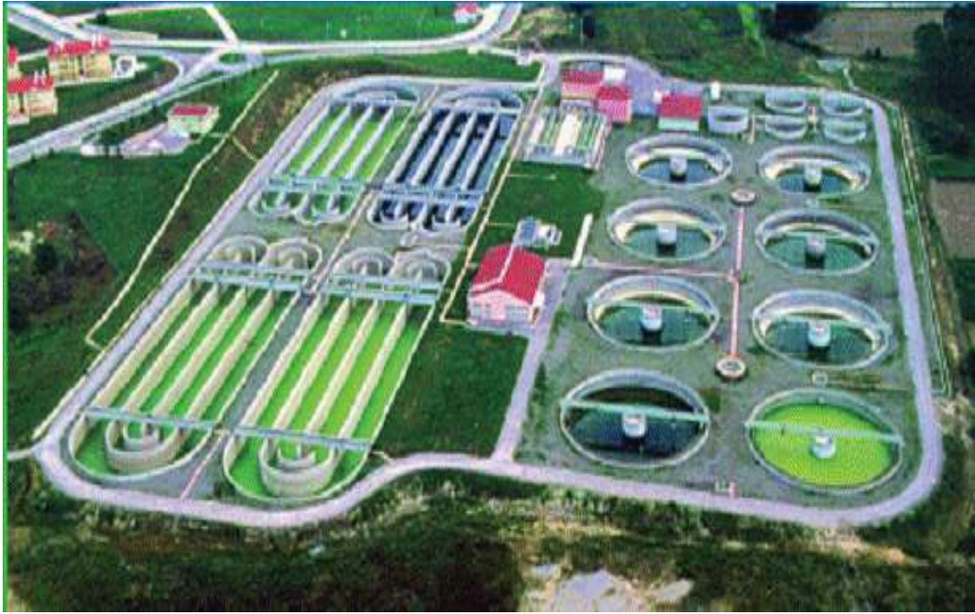
Şekil 4.1. SASKİ Arıtma Tesisinin Kuşbakışı Görünüşü [51]
