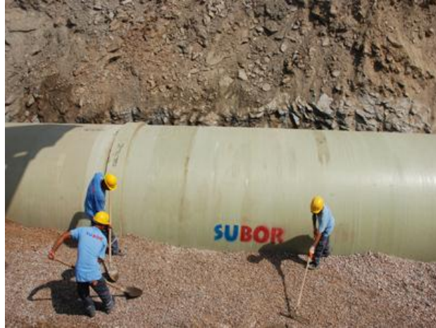
Şekil 4.1. CTP boru montajı görünümü [29]
