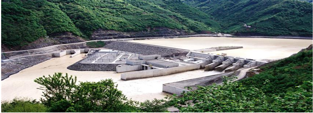
Şekil 4.2. Muratlı Barajı ve Hes (Küsmez,2015).
