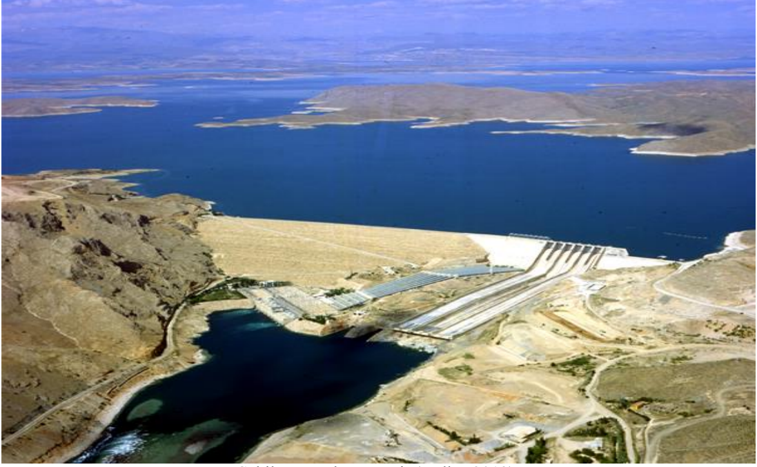
Şekil 4.8. Keban Barajı (Dalkır,2013).
