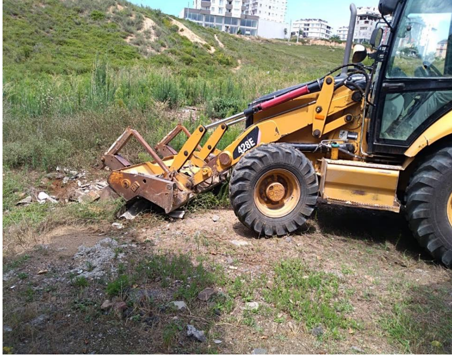
Şekil 4.10. İnşaat ve yıkıntı atıkları toplama çalışması
