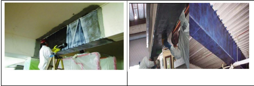
Şekil 2.10. FRP malzemenin kirişlerde uygulanması
