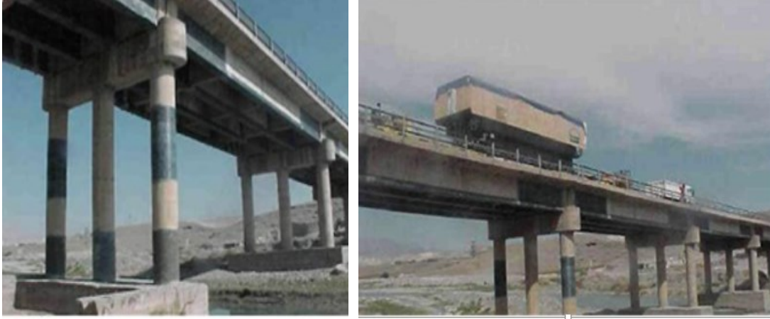
Şekil 1.4. Göksu köprüsü güçlendirme çalışması
