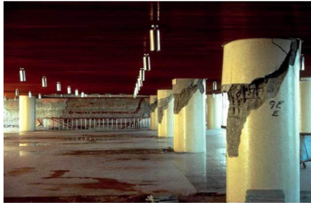
Şekil 1.2. Daire kesitli kolonların hasarı [41]
