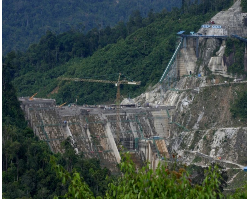
Şekil 3.15. Malezya-Murum barajı genel görünüm
