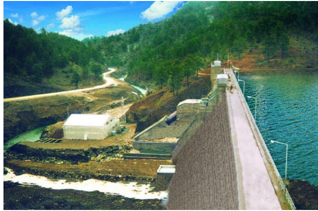
Şekil 3.7. Kahramanmaraş Suçati barajı
