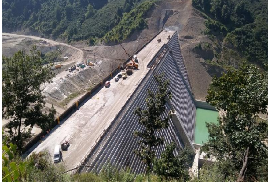
Şekil 3.9. Sakarya Ballıkaya barajı genel görünüm
