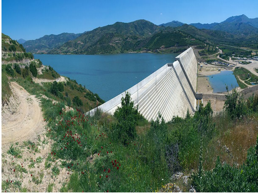
Şekil 3.2. İzmir Beydağ barajı genel görünüm
