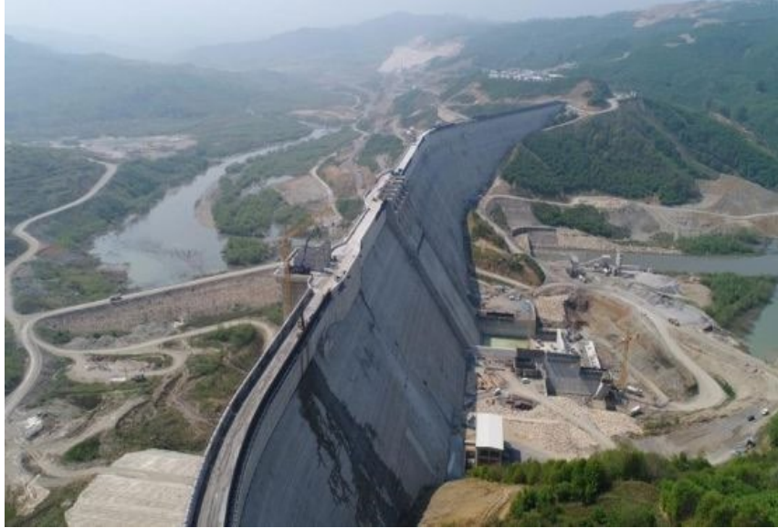
Şekil 3.8. Sakarya Melen barajı genel görünüm
