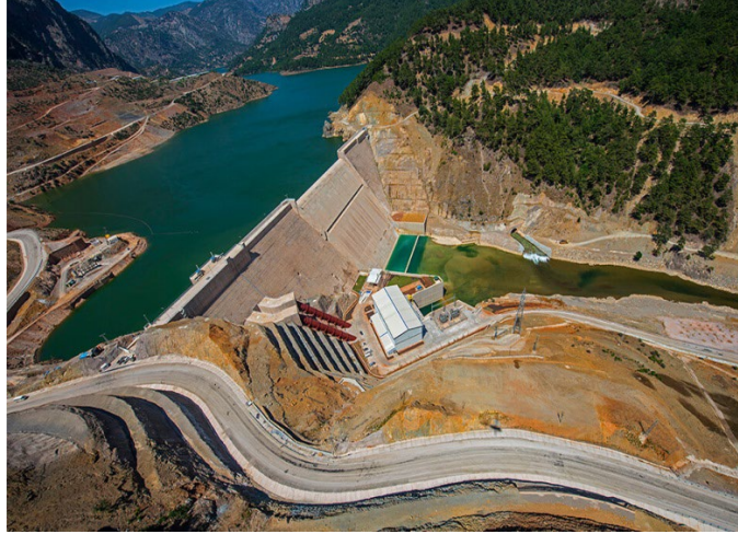
Şekil 3.5. Adana Köprü barajı genel görünüm
