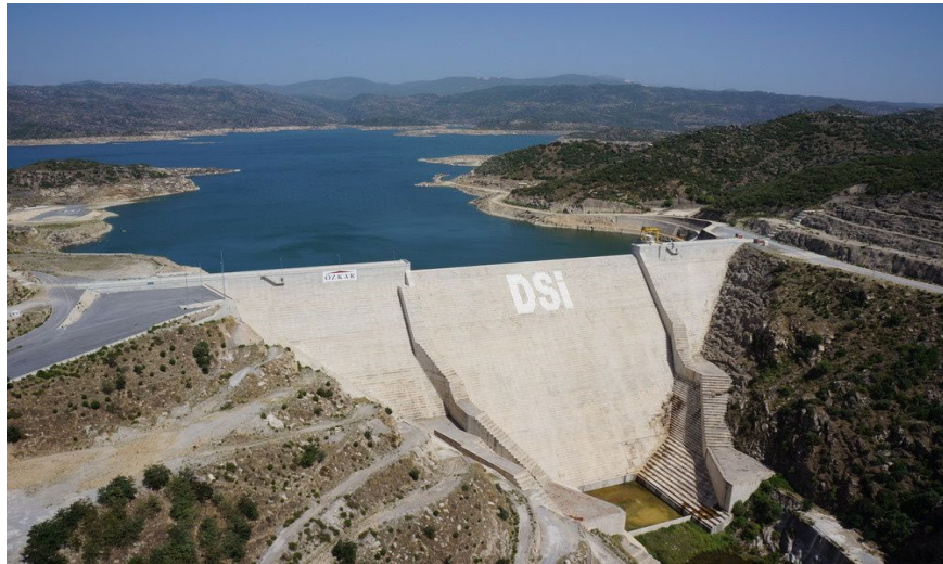
Şekil 3.4. Aydın Çine barajı genel görünüm
