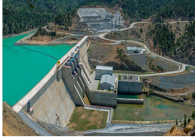
Şekil 3.6. Adana Menge barajı genel görünüm
