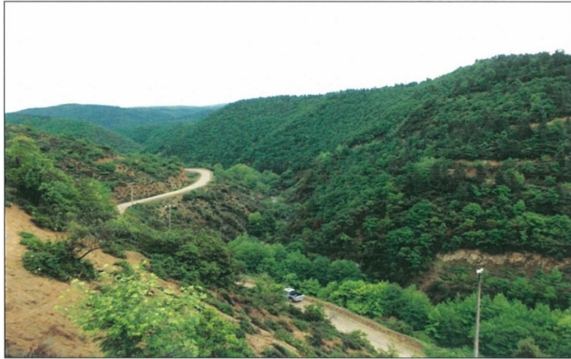
Şekil 5.6. Baraj göl alanı genel görünüm
