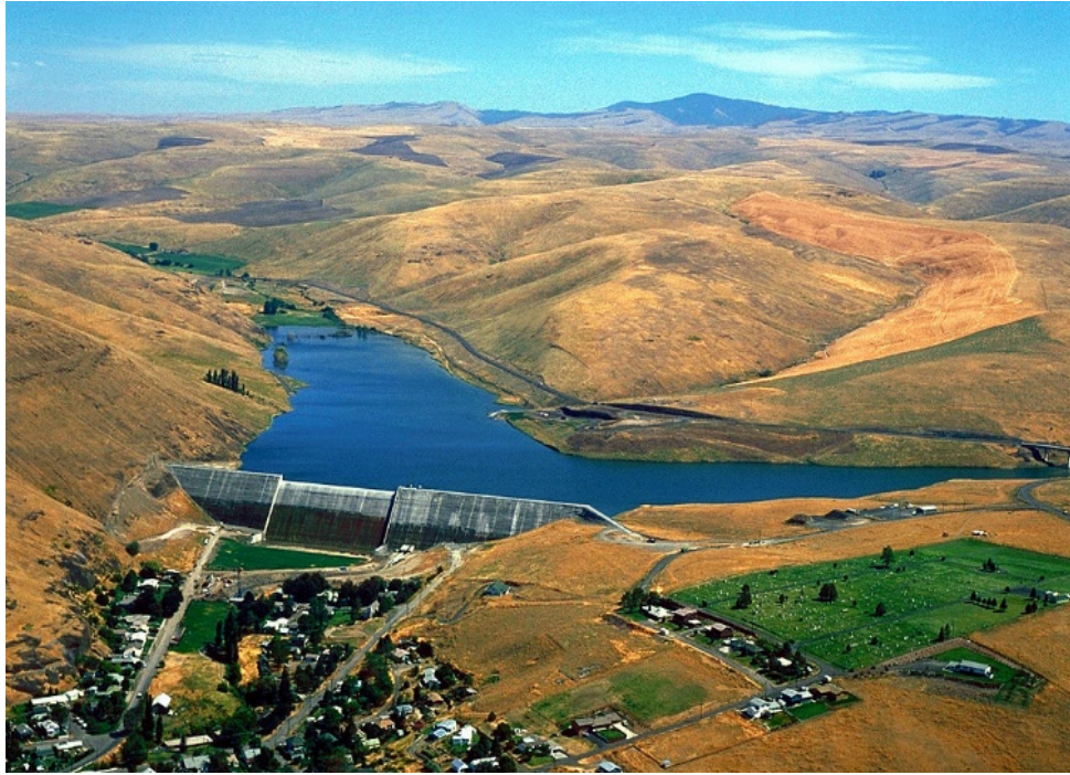
Şekil 3.10. ABD Willow Creek barajı genel görünüm
