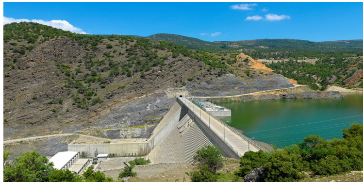
Şekil 3.3. Denizli Cindere barajı genel görünüm
