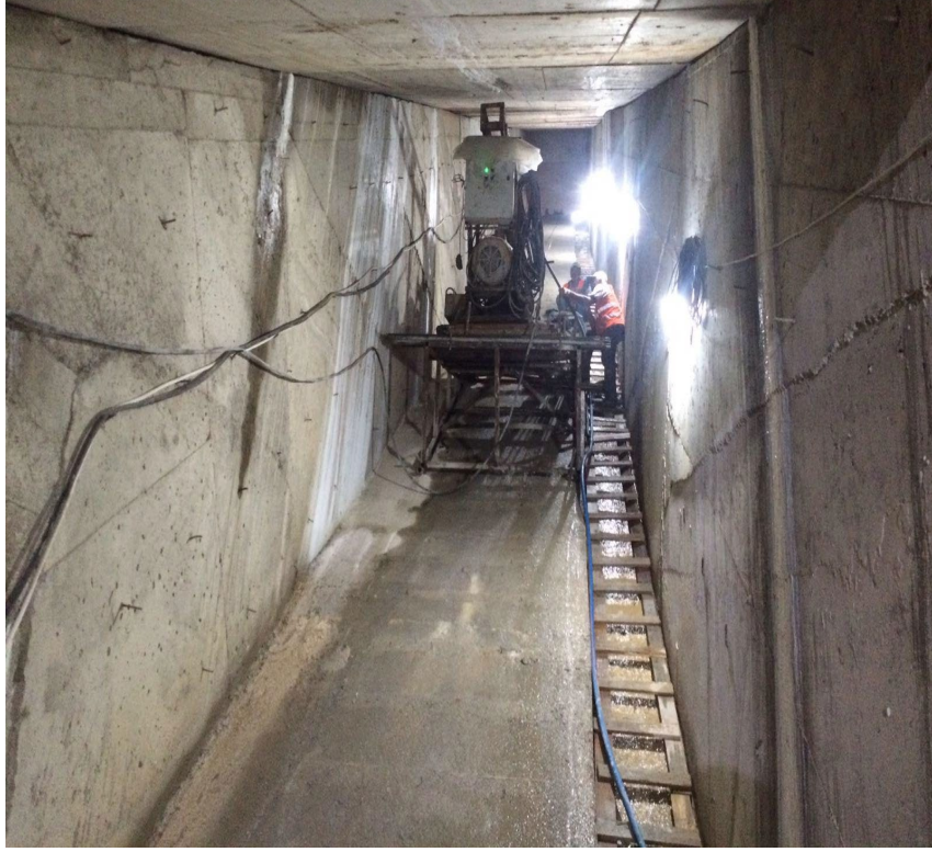
Şekil 8.2. Eğimli galeride enjeksiyon yapılması
