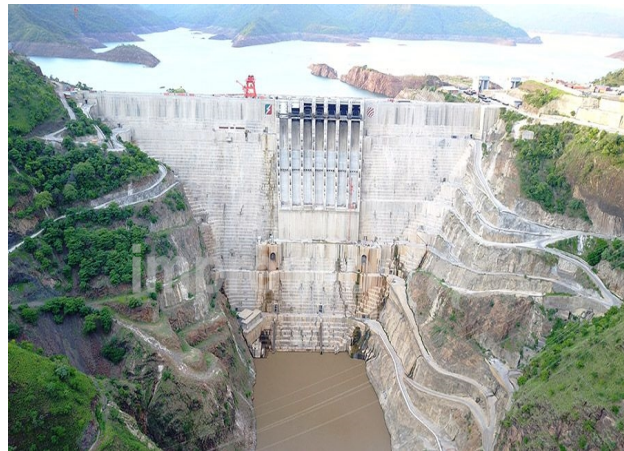
Şekil 3.13. Etopya-Gibe III barajı genel görünüm
