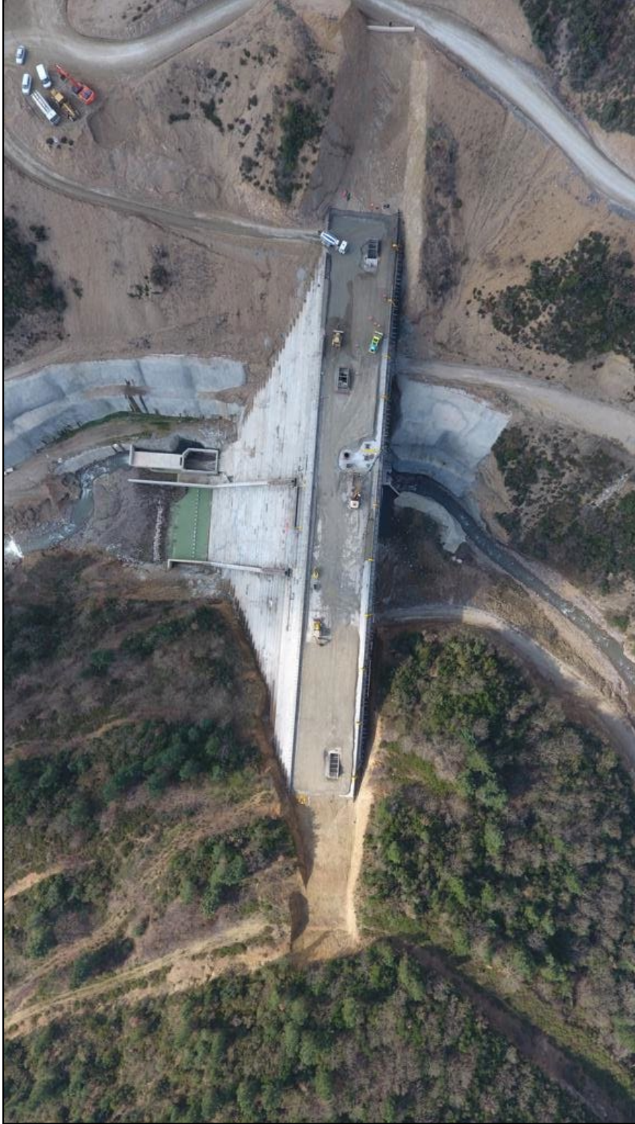
Şekil 5.3. İhsaniye barajı inşa görüntüsü
