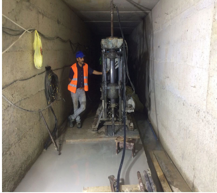
Şekil 8.1. Düz galeride enjeksiyon yapılması
