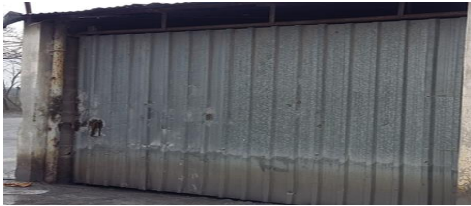
Őekil 5.2. Tehlikeli Atık Ambarı
