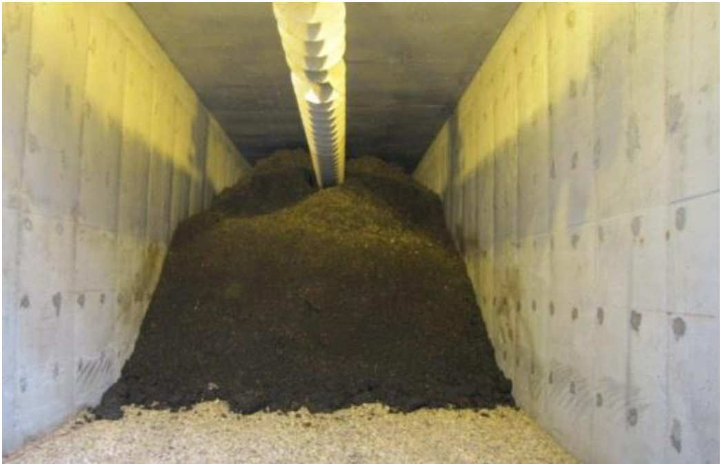
Şekil 2.15. Kapalı Statik Yığın (Tünel) Dolum Örneği [23]
