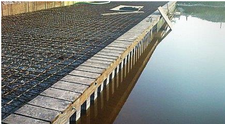
Şekil 3.5. Korozyon riski yüksek sahada bazalt donatı kullanımı (URL-11)
