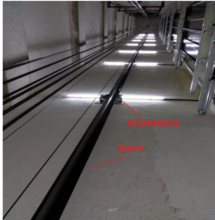
Şekil 4.3. Ray Montajı
