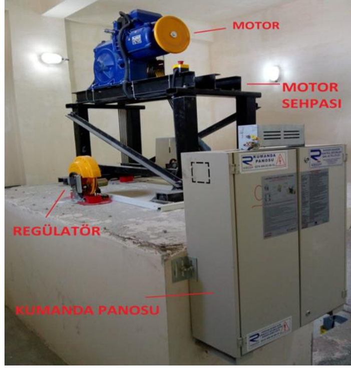
Şekil 4.5. Makine Dairesi Montajı
