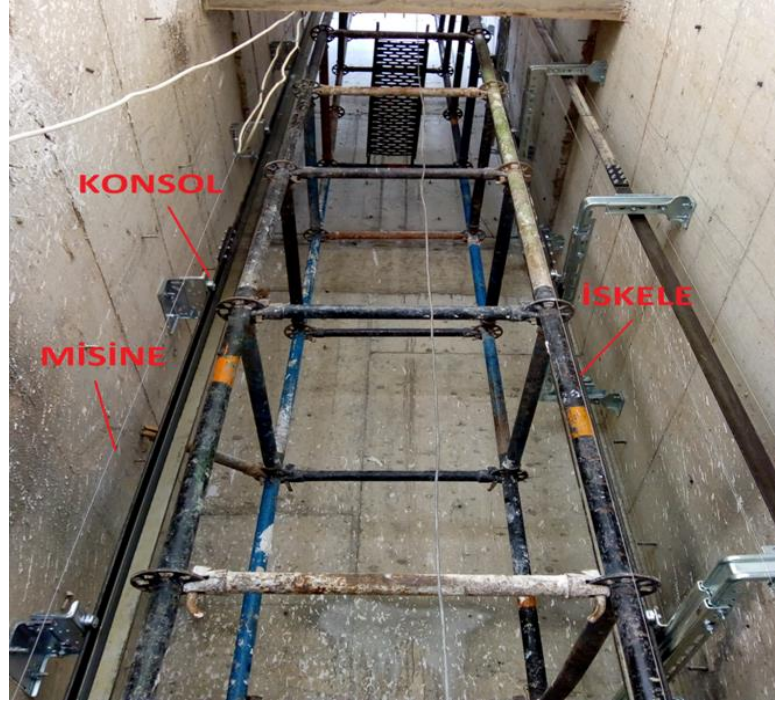
Şekil 4.2. İskele Kurulumu ve Röleve İşlemi
