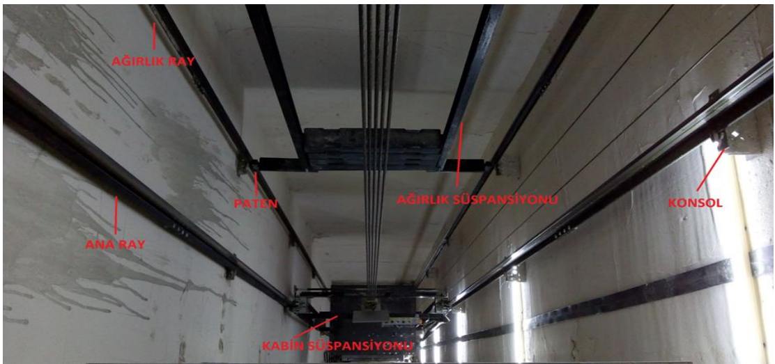
Şekil 4.7. Kabin ve Ağırlık Süspansiyonu
