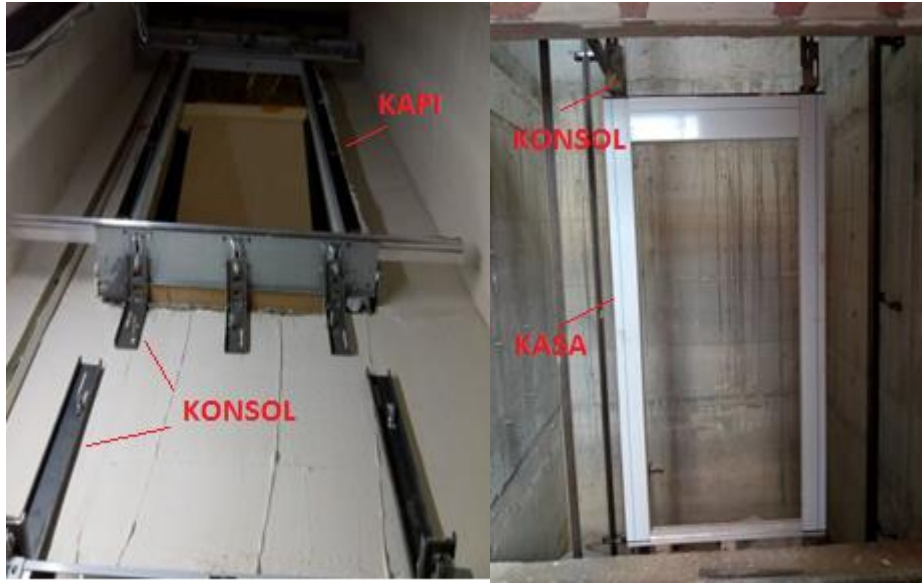
Şekil 4.4. Kapı Kasalarının Konsollar İle Sabitlenmesi
