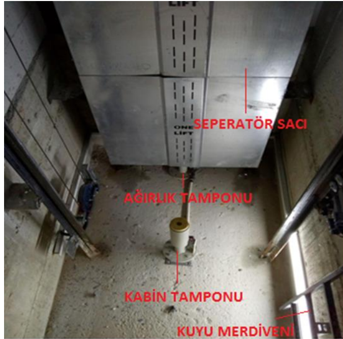
Şekil 4.12. Kuyu Dibi Görünüm
