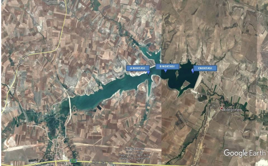
Şekil 3.26. Akdeğirmen Barajı uydu görüntüsü ile A, B ve C noktalarının konumu
