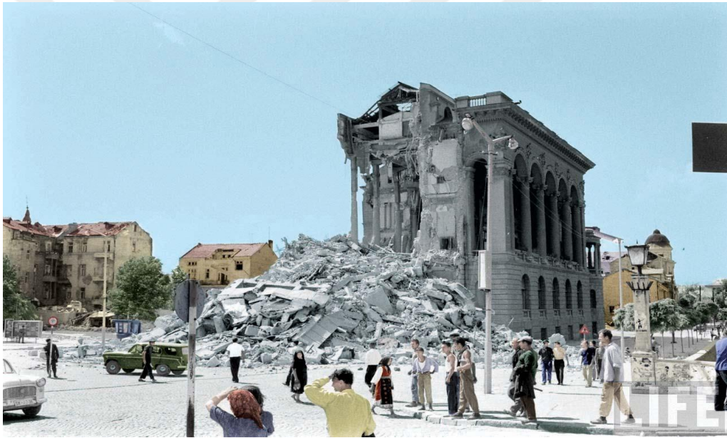
Şekil 1.5. 1963 Üsküp depreminde hasar gören bir yığma yapı [6]
