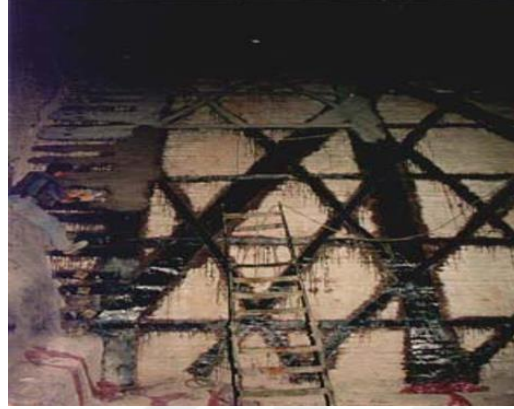
Şekil 2.20. Yığma kemer üzerinde CFRP uygulaması [54]
