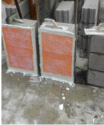
Şekil 3.9. Sismik kumaşın bindirmeli olarak uygulanması
