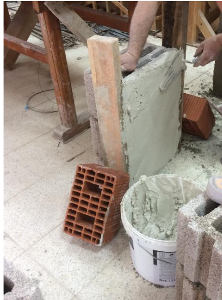
Şekil 3.4. Beyaz çimento ve doğal su kireci esaslı sıvanın numuneye uygulanması
