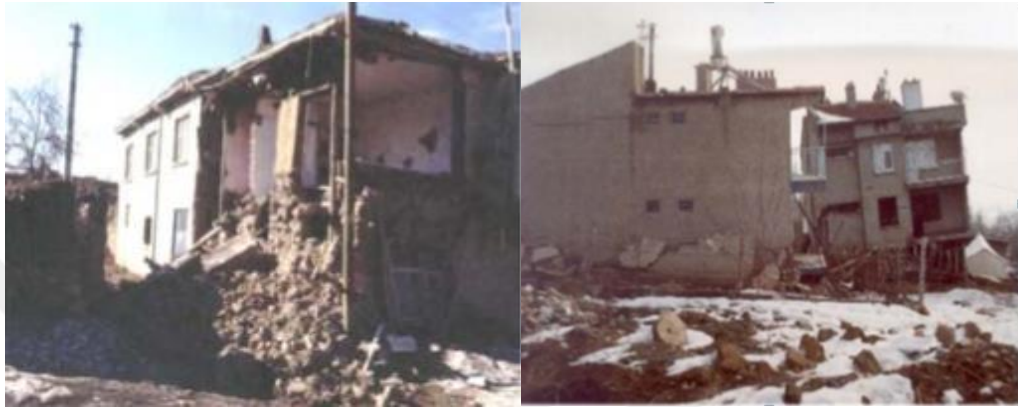
Şekil 1.11. 2002 Sultandağı depreminde hasar gören yığma yapılar [16]
