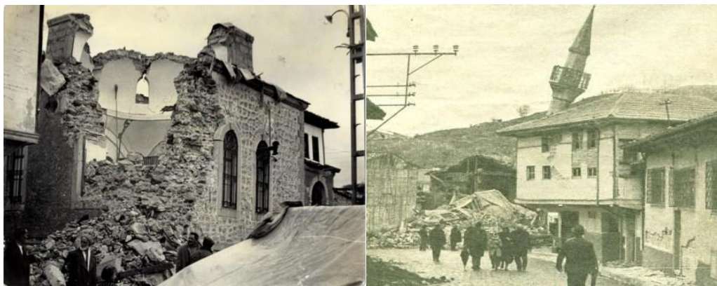
Şekil 1.9. 1970 Gediz depreminde hasar gören yapılar [10]
