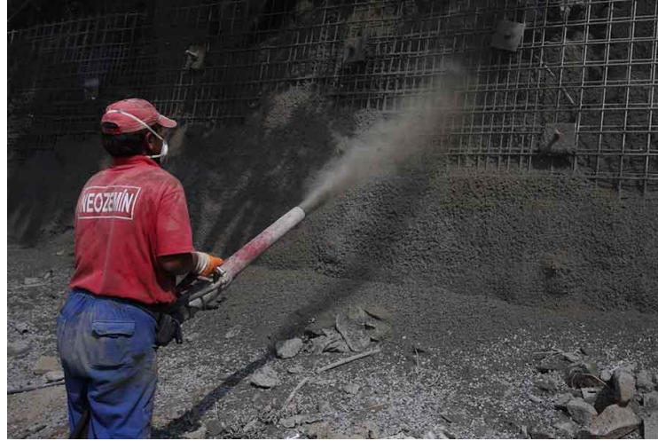
Şekil 2.12.Püskürtme beton uygulaması [51]
