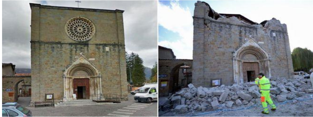
Şekil 1.7. 2016 İtalya-Amatrice depreminde hasar gören tarihi yığma kilise [7]
