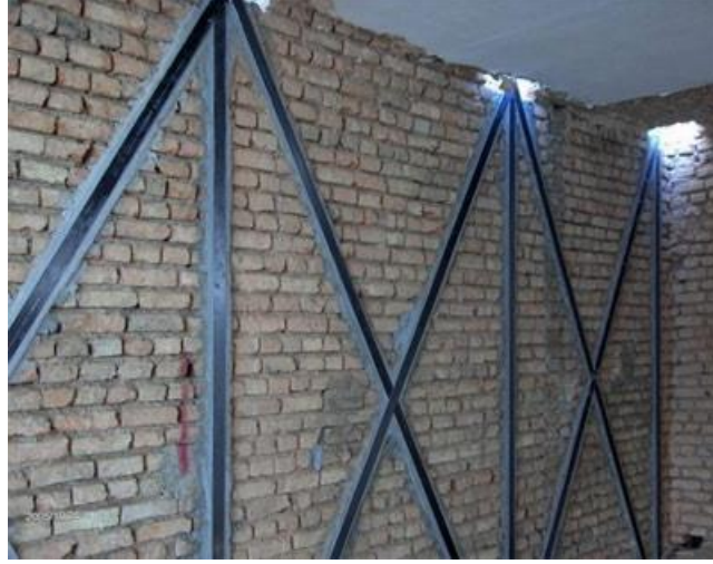
Şekil 2.15. Çelik elemanlarla güçlendirme örneği
