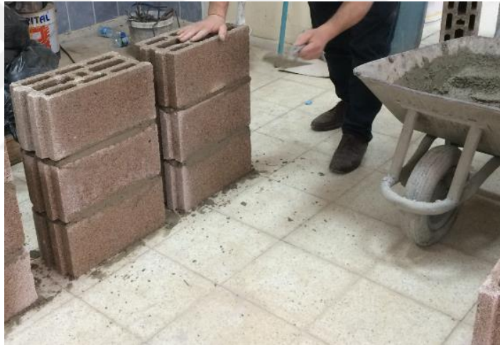
Şekil 3.2. Üçlü bims blok numunelerinin yapım aşaması
