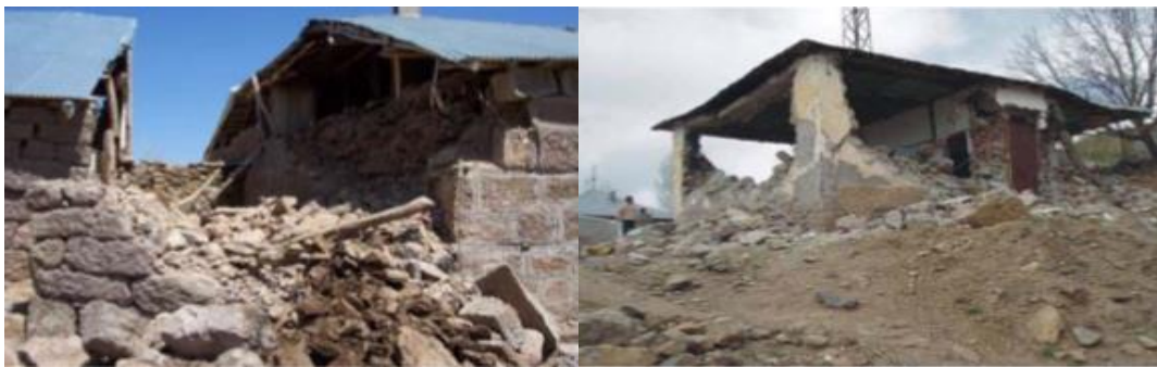
Şekil 1.12. 2003 Bingöl depremi sonrası hasar gören yapılar [16]
