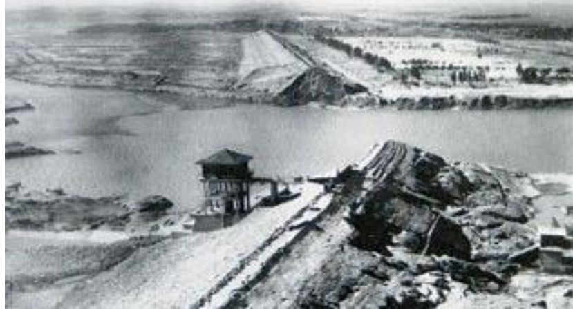
Şekil 1.1. Yıkımdan sonra Banqiao Barajı [2].
