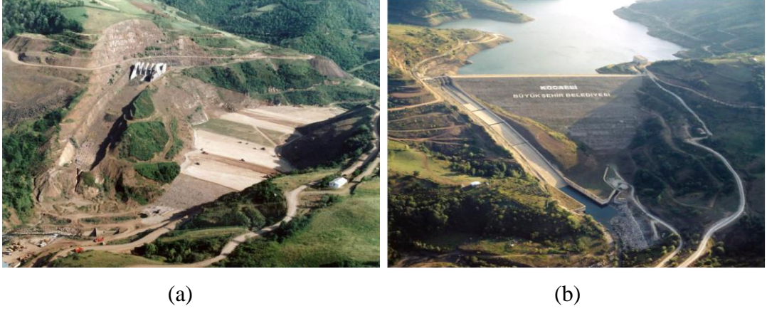
Şekil 3.5. (a) Yapım aşamasında Kirazdere Barajı görünümü (b) Tamamlanmış Kirazdere Barajı görünümü [20].
