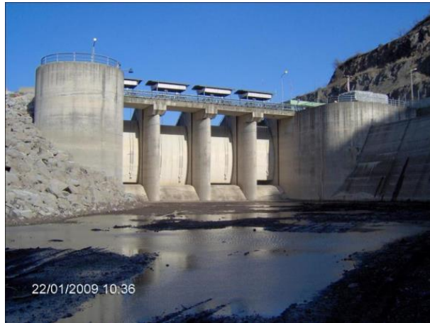
Şekil 3.6. Kirazdere Barajı dolusavak görünümü [20].
