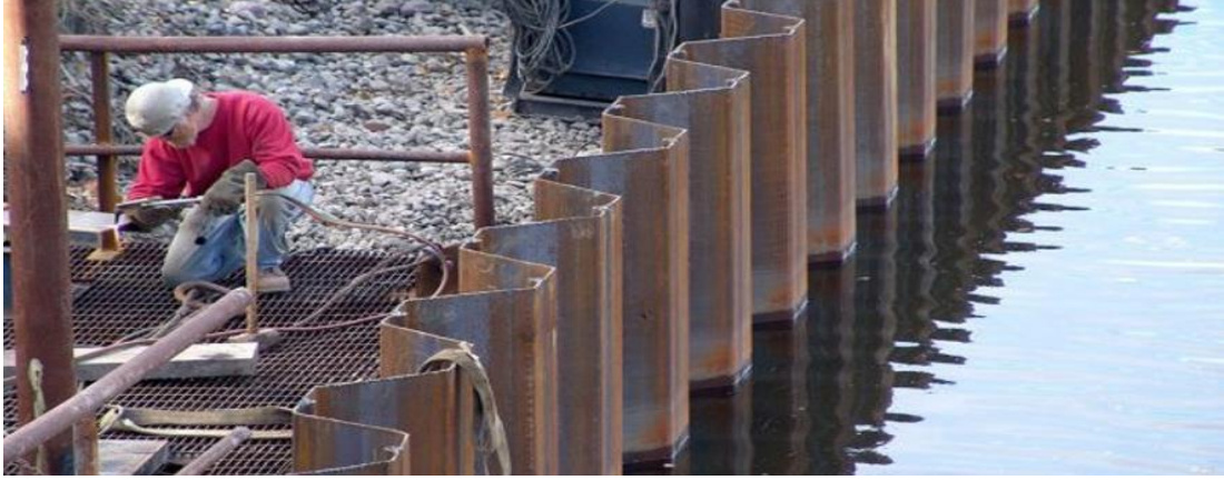
Şekil 3.14. Çelik palplanş perde uygulaması [22].
