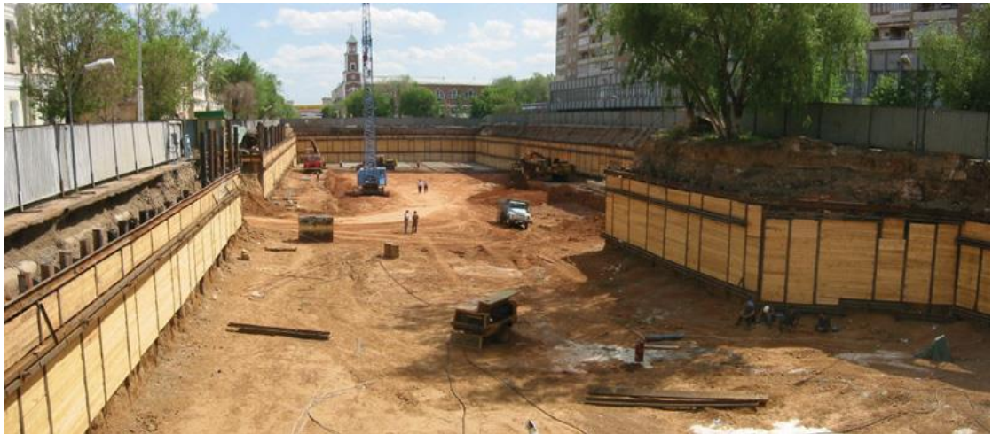
Şekil 3.12. Ahşap palplanş perde uygulaması [16].
