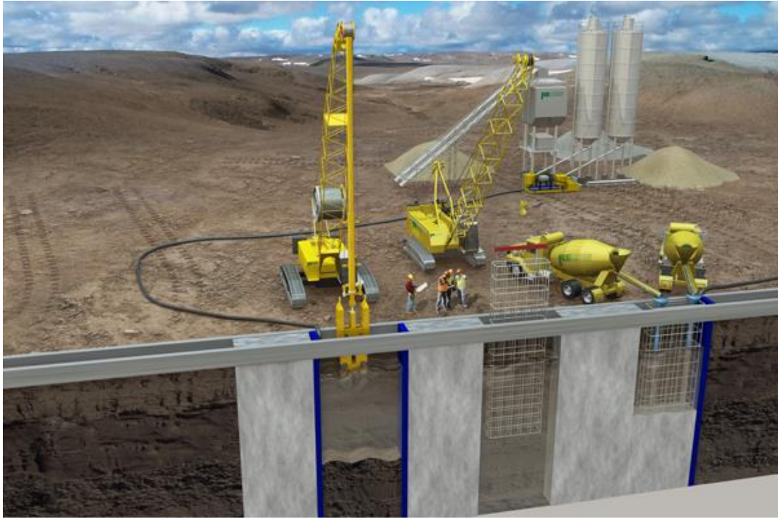
Şekil 7.6. Diyafram duvar uygulaması [72].
