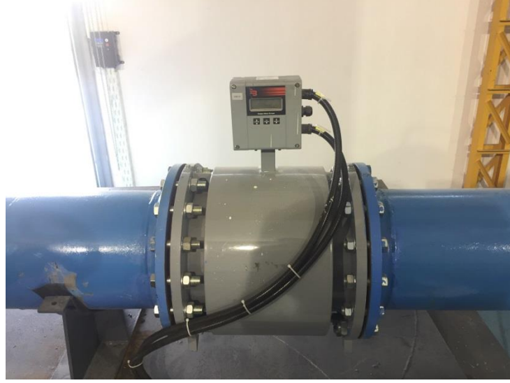
Şekil 4.4. Manyetik debimetre
