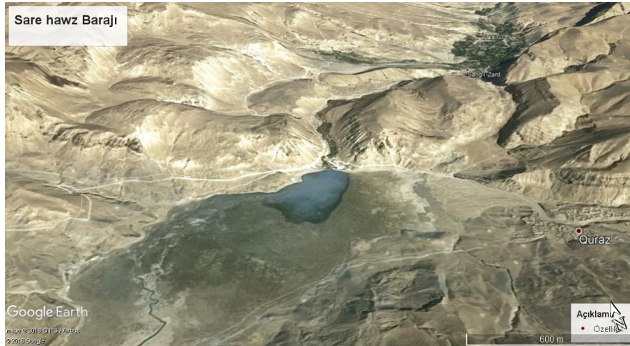
Şekil 3.4. Sare Hawz barajı uydu görünümü
