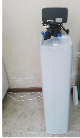
Şekil 3.5. Pilot tesislerde kullanılan su yumuşatma ünitesi
