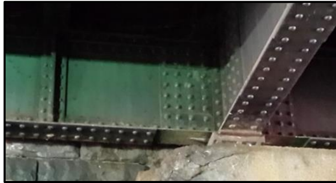
Şekil 4.2. Köprü birleşim tipi örneği [3] [28]
