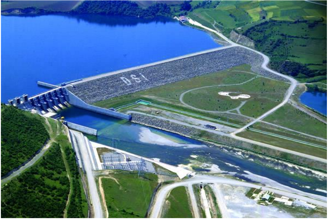
Şekil 4.5. Derbent Barajı'nın görüntüsü [37].
