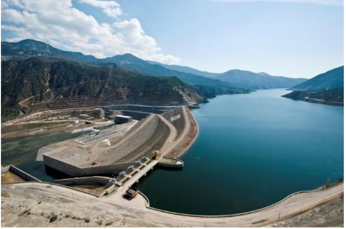
Şekil 4.2. Obruk Barajı'nın Görüntüsü [34].
