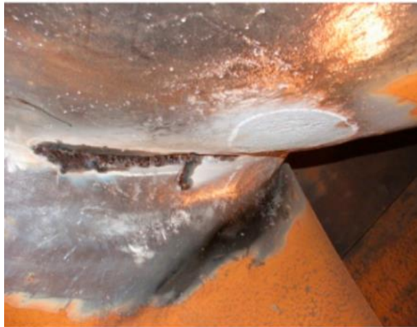
Şekil 3.4. Kılavuz kanadına ait bir eroziyon aşınma örneği [13].
