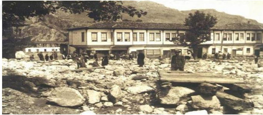
Şekil 2.18. Amasya'da 1948 taşkınında taşkın getirmiş olduğu taş ve sediment taşınımı (Güngör, 2010)
