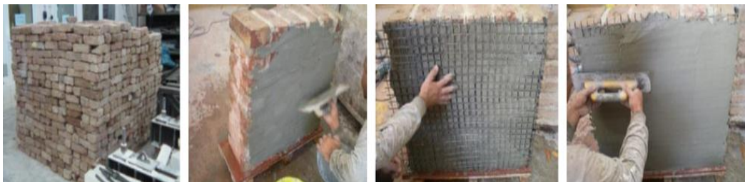
Şekil 1.8. Yığma binadan alınan tuğlalar ve duvarlara uygulanan güçlendirme işlemi aşamaları [14]
