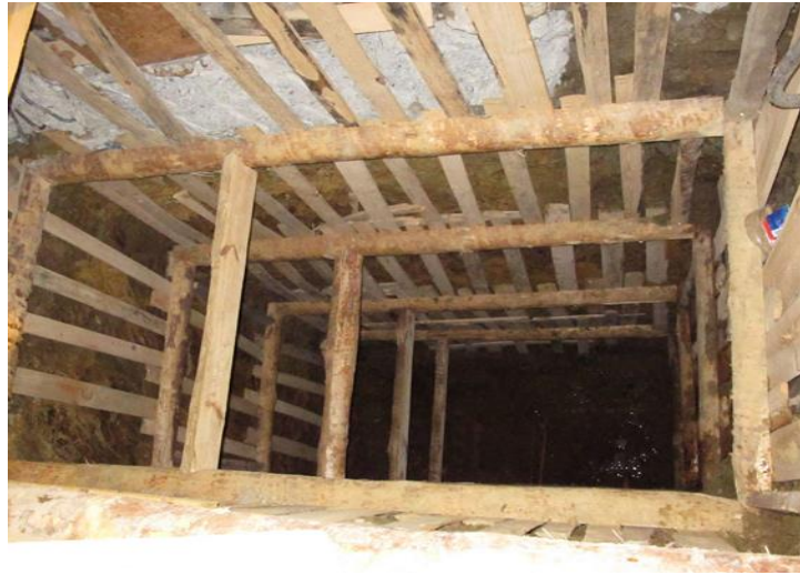
Şekil 3.4. Kuyu duvar uygulaması
