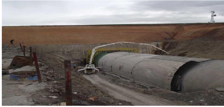
Şekil 3.5. Aç-kapa kazı yöntemi
