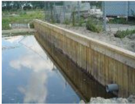
Şekil 3.18. Ahşap palplanş perde uygulaması
