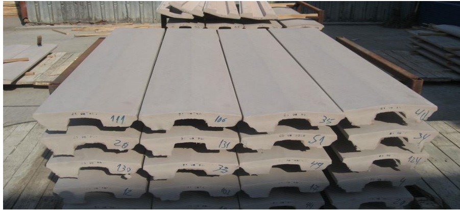
Şekil 3.19. Betonarme palplanş perde uygulaması
