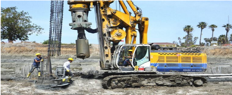
Şekil 3.23. Fore kazık makinesi
