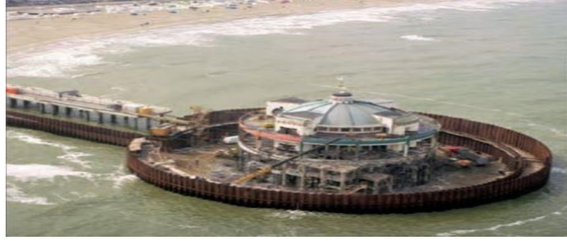
Şekil 3.20. Çelik palplanş perde uygulaması
