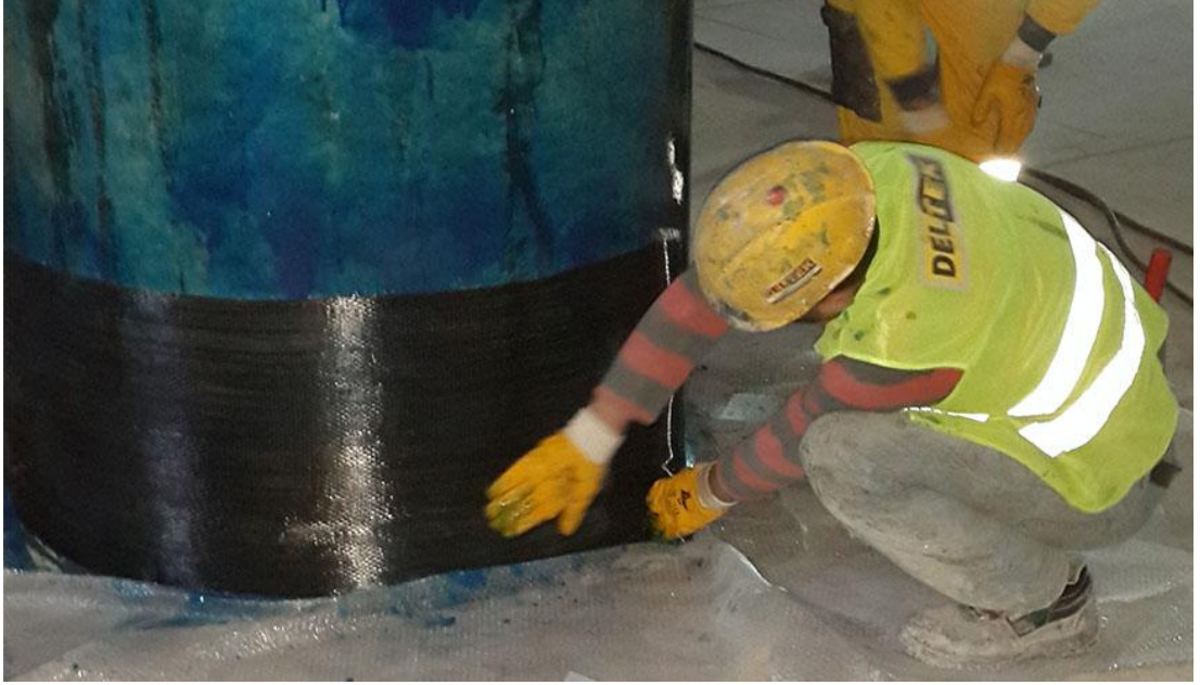
Şekil 2.5. FRP kumaş uygulaması [20]
