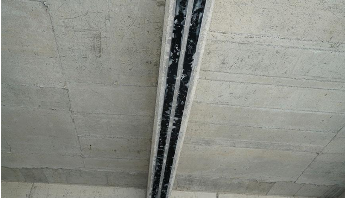
Şekil 2.4. FRP plaka uygulaması [20]
