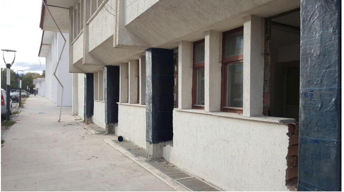
Şekil 2.8. Betonarme kolonlara FRP uygulaması [21]
