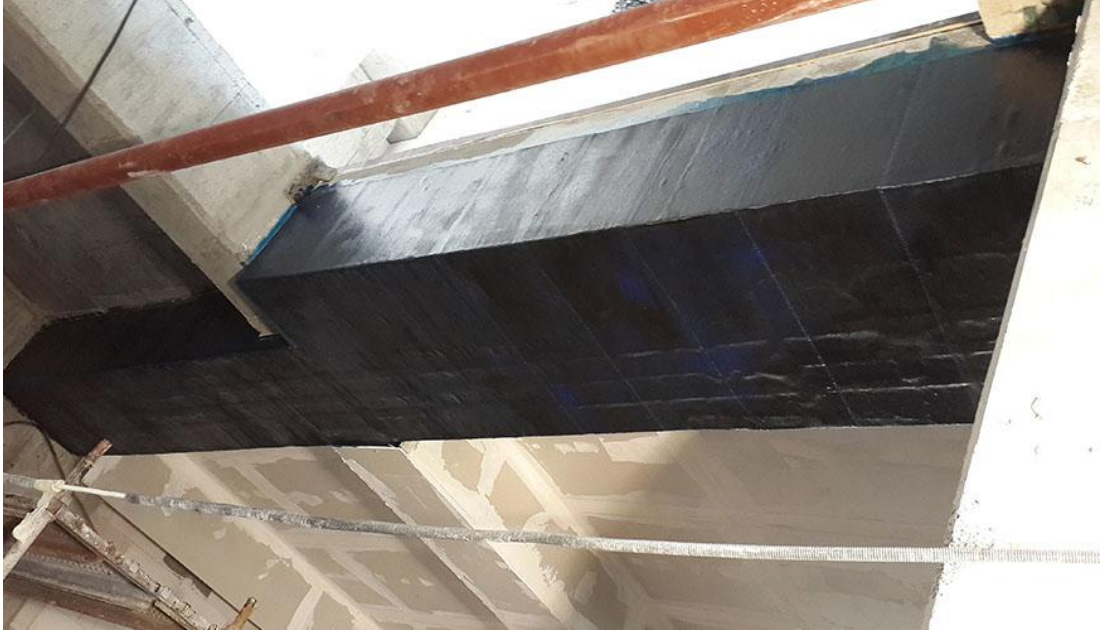
Şekil 2.7. FRP kumaş uygulaması [20]
