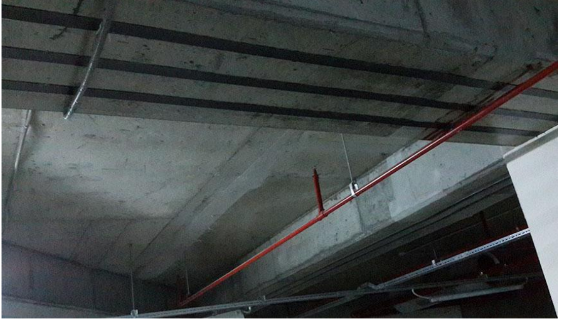
Şekil 2.3. FRP plaka uygulaması [20]
