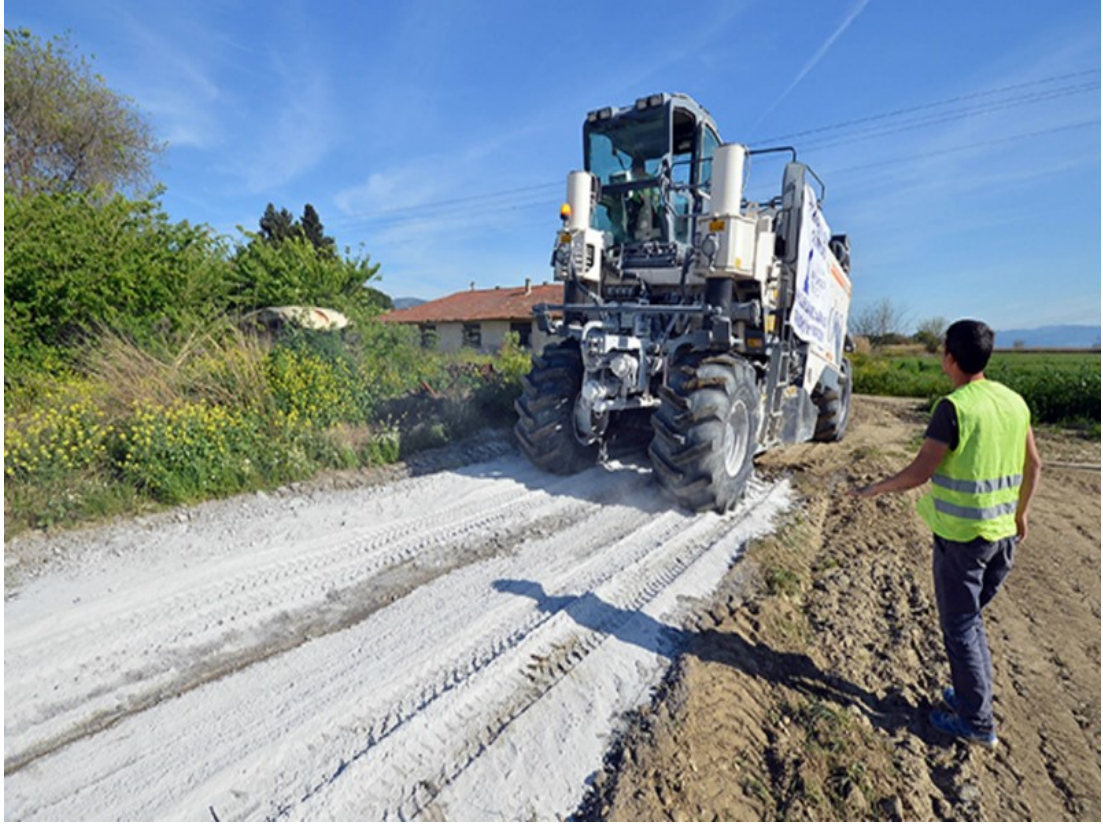
Şekil 2.3. Killi zeminin kireç ile stabilizasyonu (URL-2)
