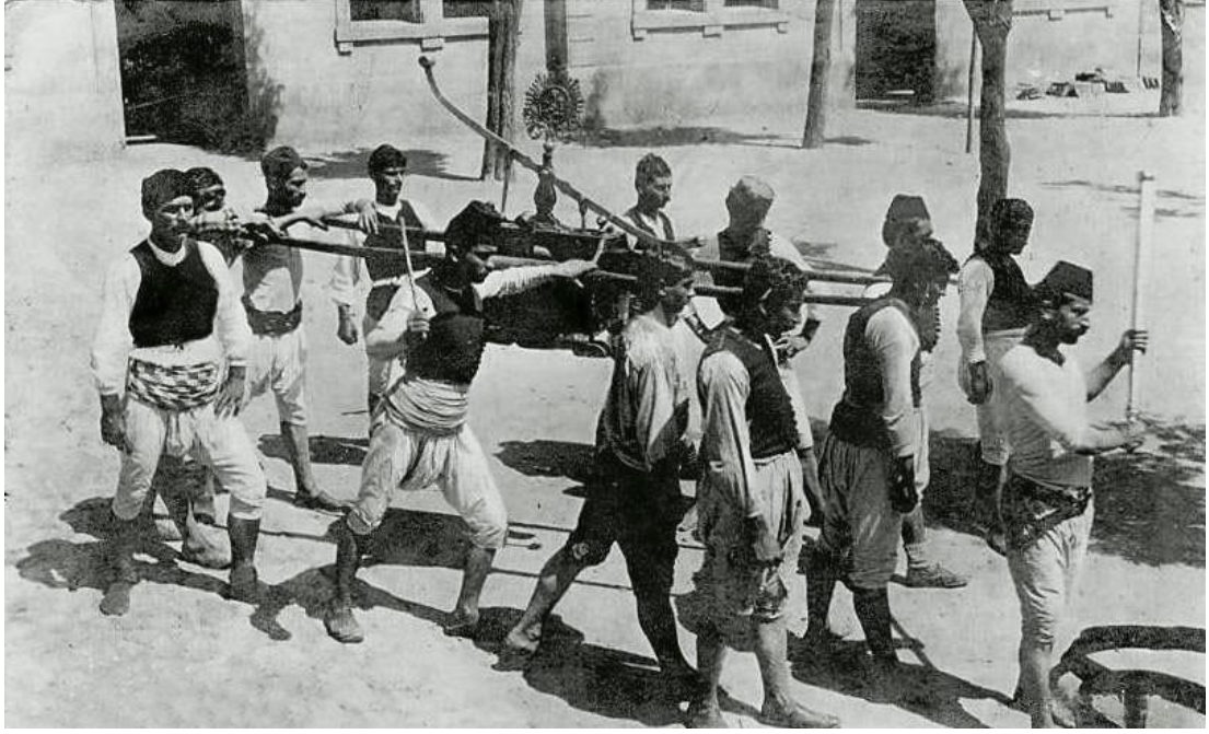
Şekil 4.3. Su Tulumbaları Yangın Yerine Taşınırken
